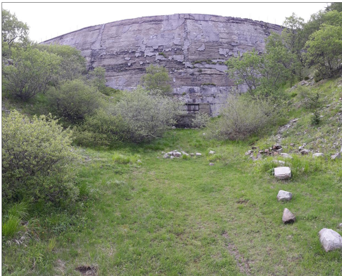
Figura 1.2. Foto del corpo diga: lato monte
