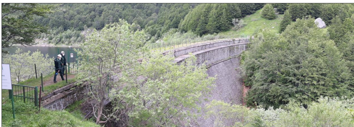
Figura 1.3. Foto del corpo diga: lato valle
