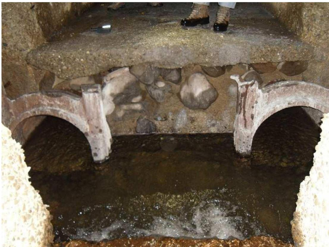
**Figura 8 Le tubazioni che fungevano da scarico di fondo**
