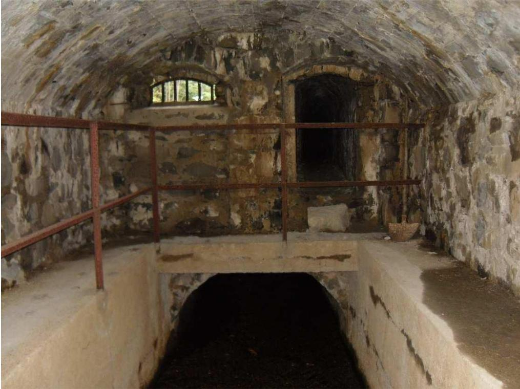
**Figura 10** Il vano dove scaricano le due tubazioni metalliche dello scarico di fondo
