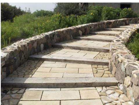
**Figura 36 - Rivestimento della scala di accesso alle banchine ed alle terrazze**
