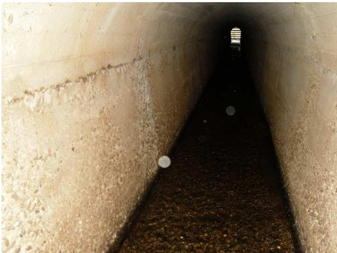
**Figura 7 Il tratto di galleria che dall'opera di presa portava alla camera delle paratoie**
