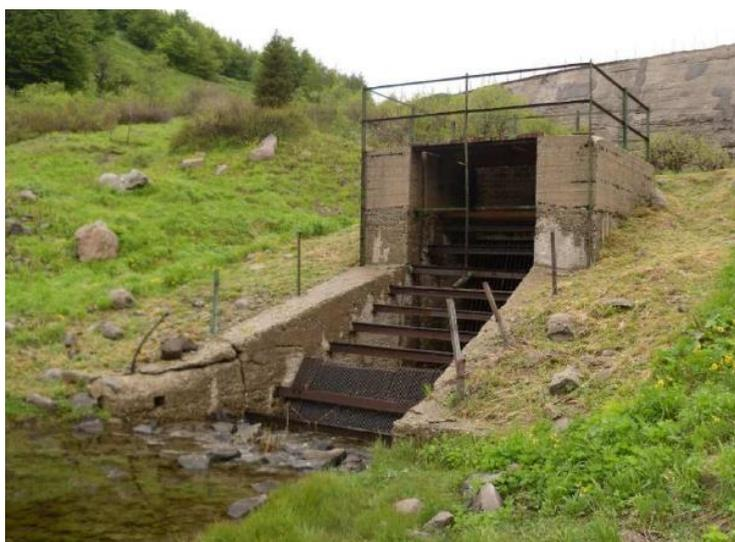
Figura 23 Imbocco dello scarico di fondo
