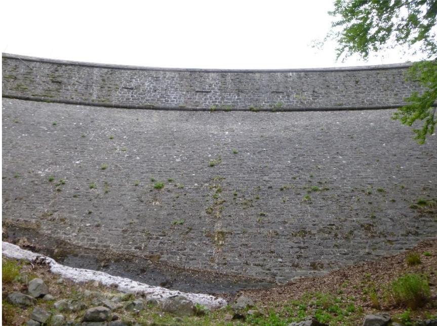
**Figura 18 Stato del paramento di valle**
