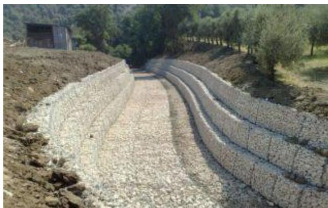
**Figura 39 - Sistemazione del fondo di un canale con gabbioni e materassi**
