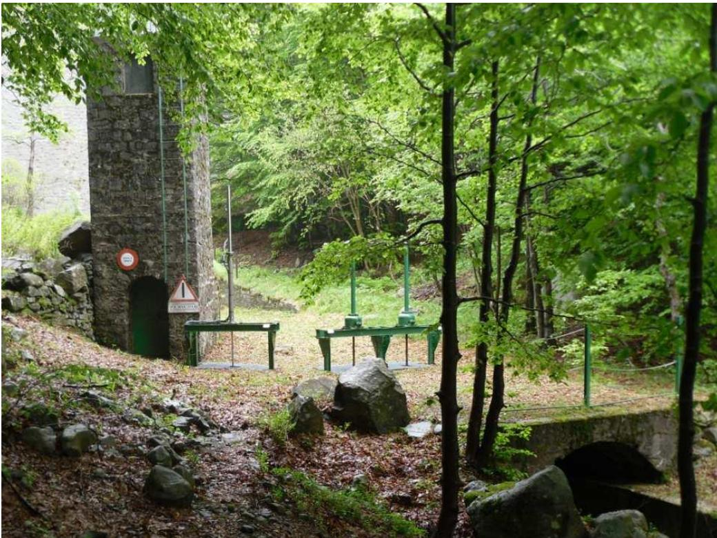
**Figura 11** Il torrino di accesso alla galleria e i comandi delle paratoie dello scarico e della derivazione
