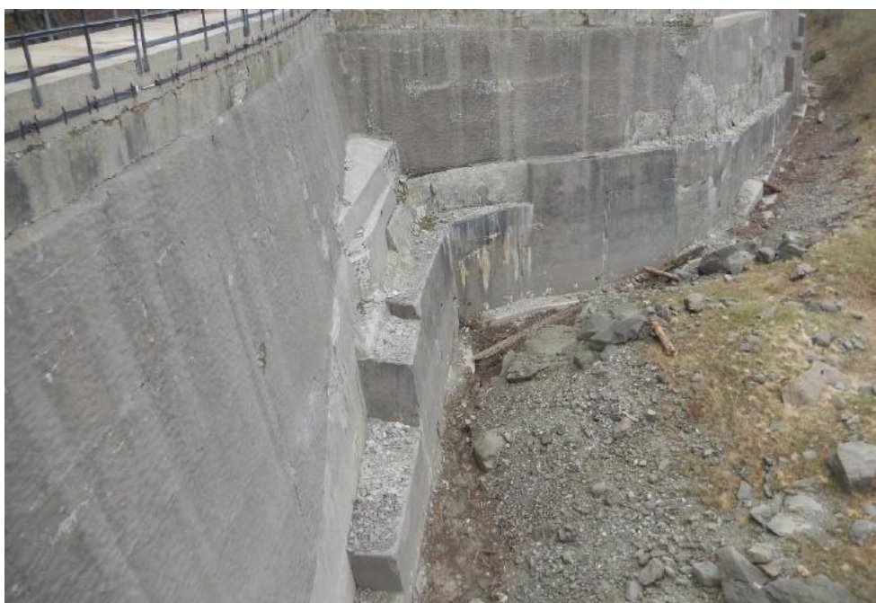
Figura 2 – Vista del paramento di monte in direzione della sponda orografica destra
