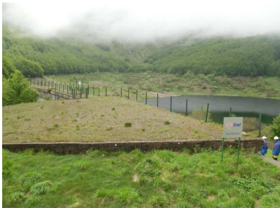
Figura 27 – Esterno dello scarico di superficie – estradosso
