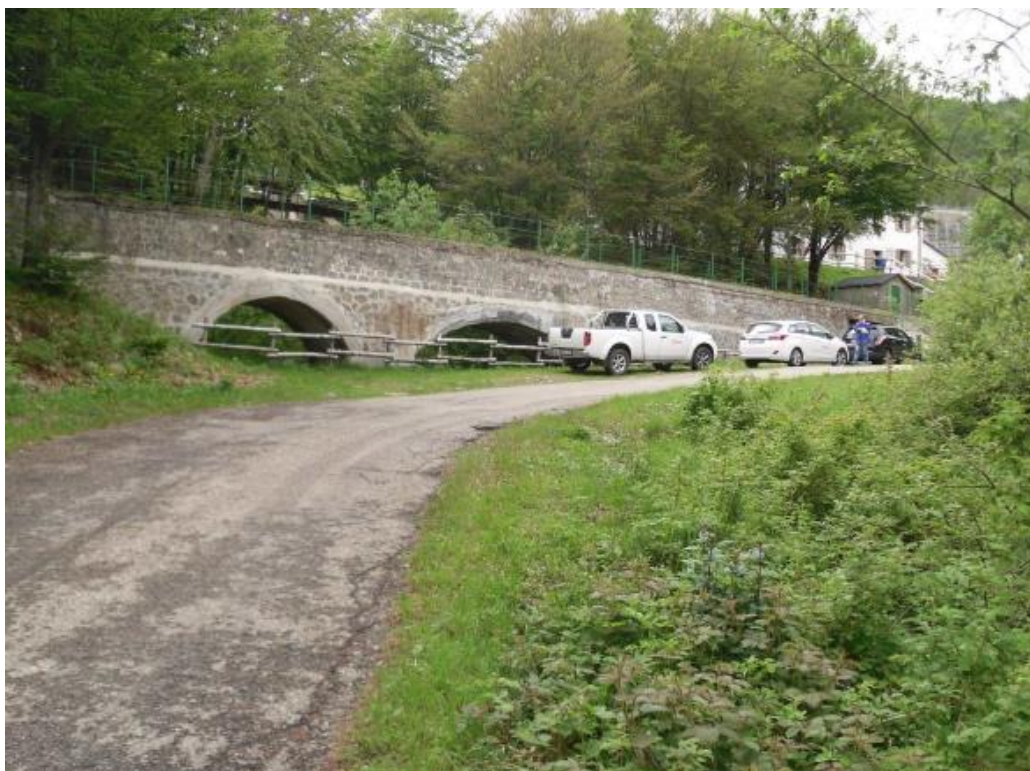
Figura 15 – Ponte canale di adduzione
