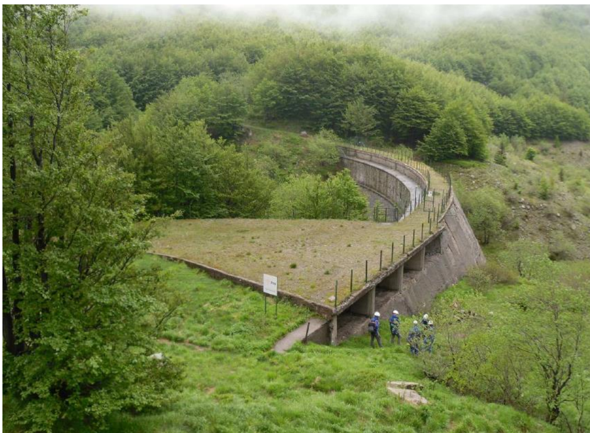
Figura 17 – Vista della diga dal versante in sponda orografica sinistra
