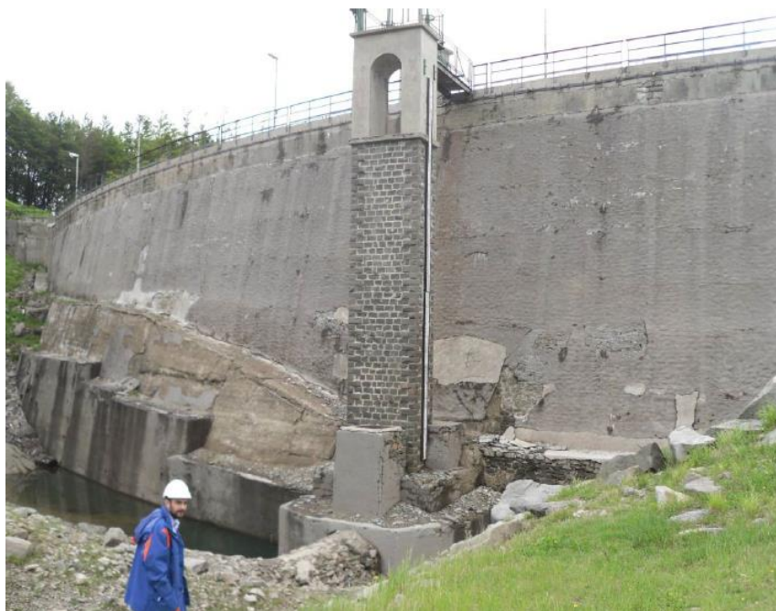
Figura 5 – Vista del torrino di comando delle paratoie dello scarico di fondo/opera di presa
