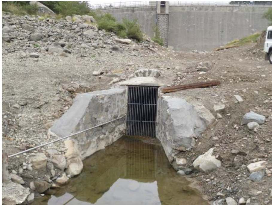
Figura 13 – Manufatto di imbocco dello scarico di fondo/opera di presa
