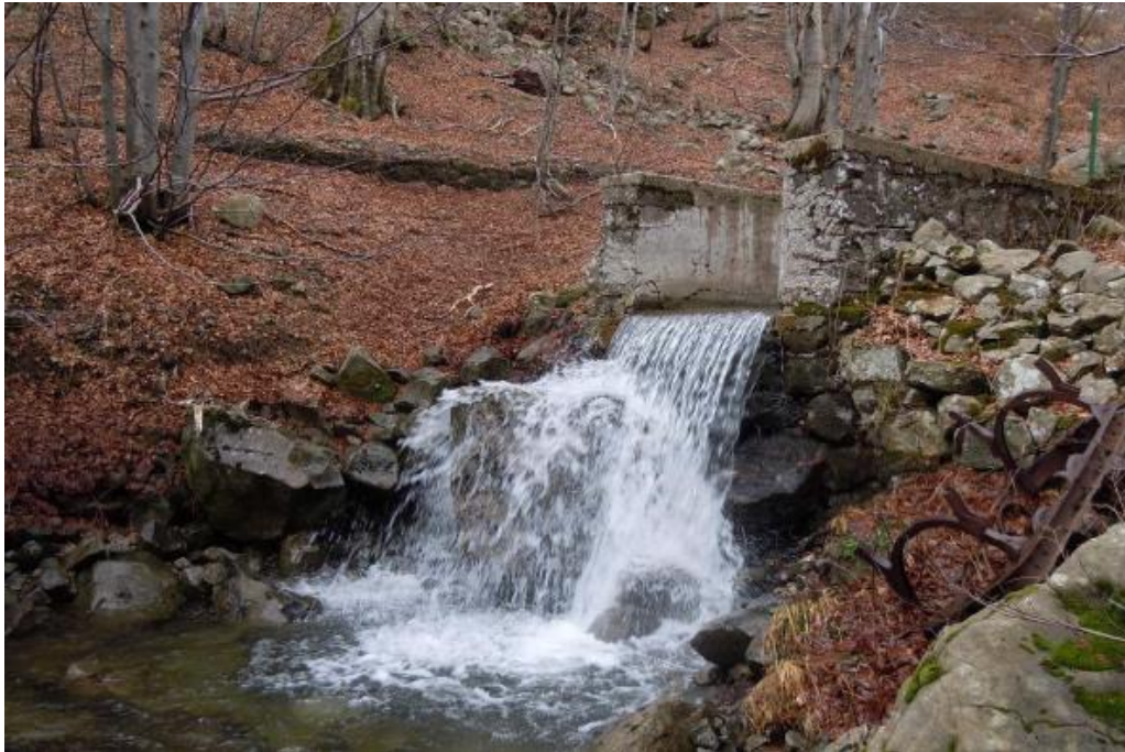
Figura 28 – Il recapito in alveo dello scarico di fondo
