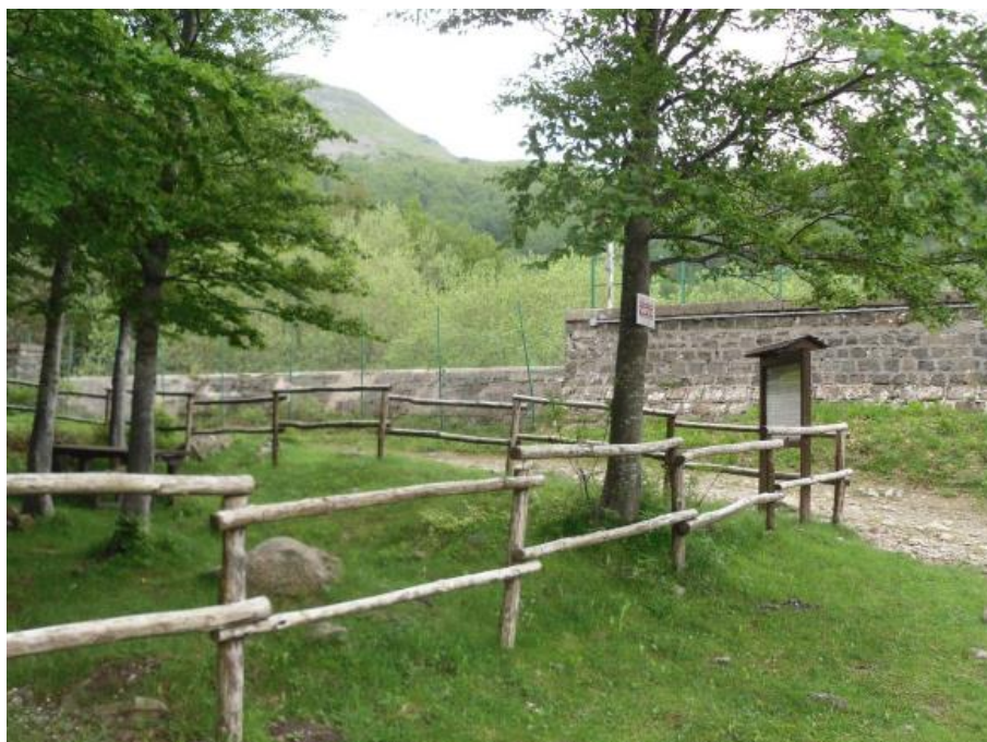
Figura 8 – Vista del paramento di valle in corrispondenza dello scarico ausiliario
