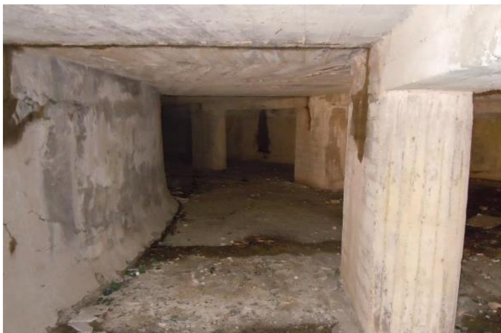
Figura 26 – Interno dello scarico di superficie
