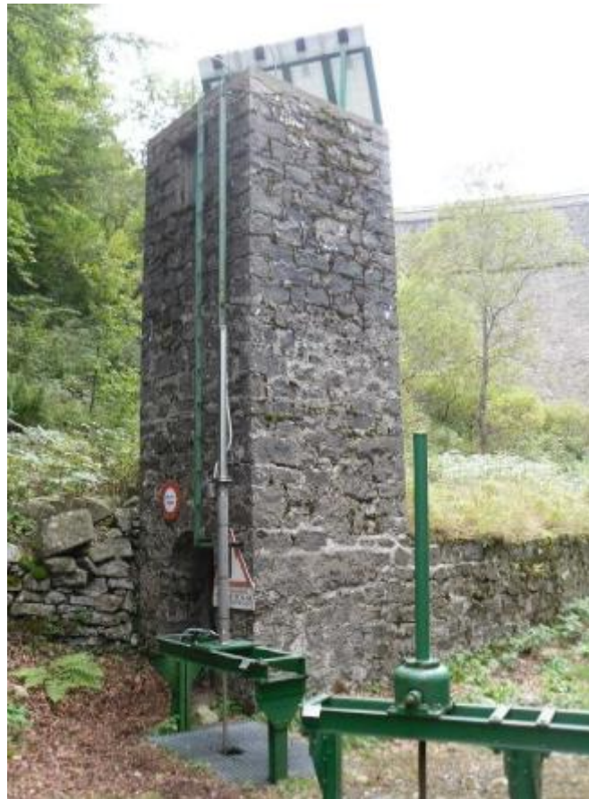
Figura 30 – Il torrino di accesso al cunicolo di ispezione
