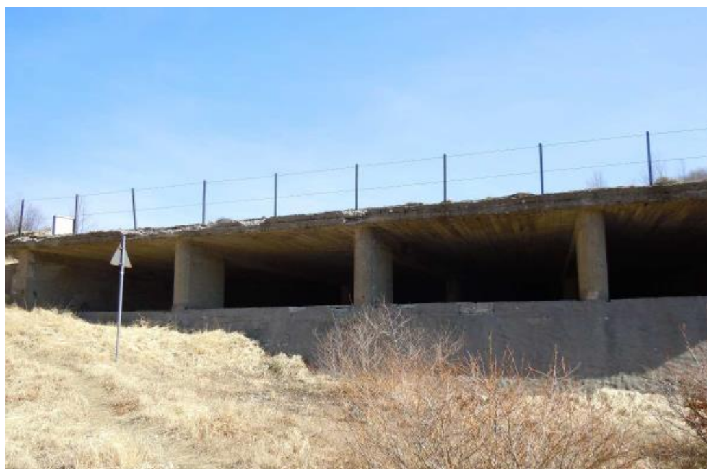
Figura 25 – Lo scarico di superficie
