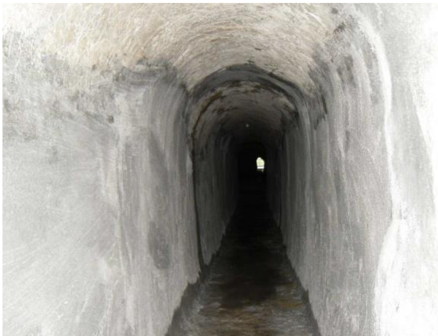
Figura 29 – La galleria nel corpo diga
