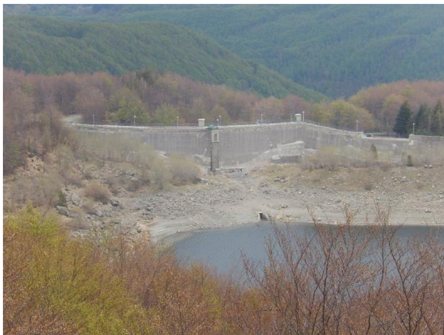
Figura 1 – Vista della diga dai pendii a monte dell'invaso
