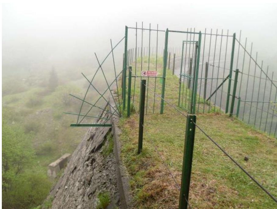
Figura 23 – Vista dell'accesso al coronamento dalla sponda orografica destra
