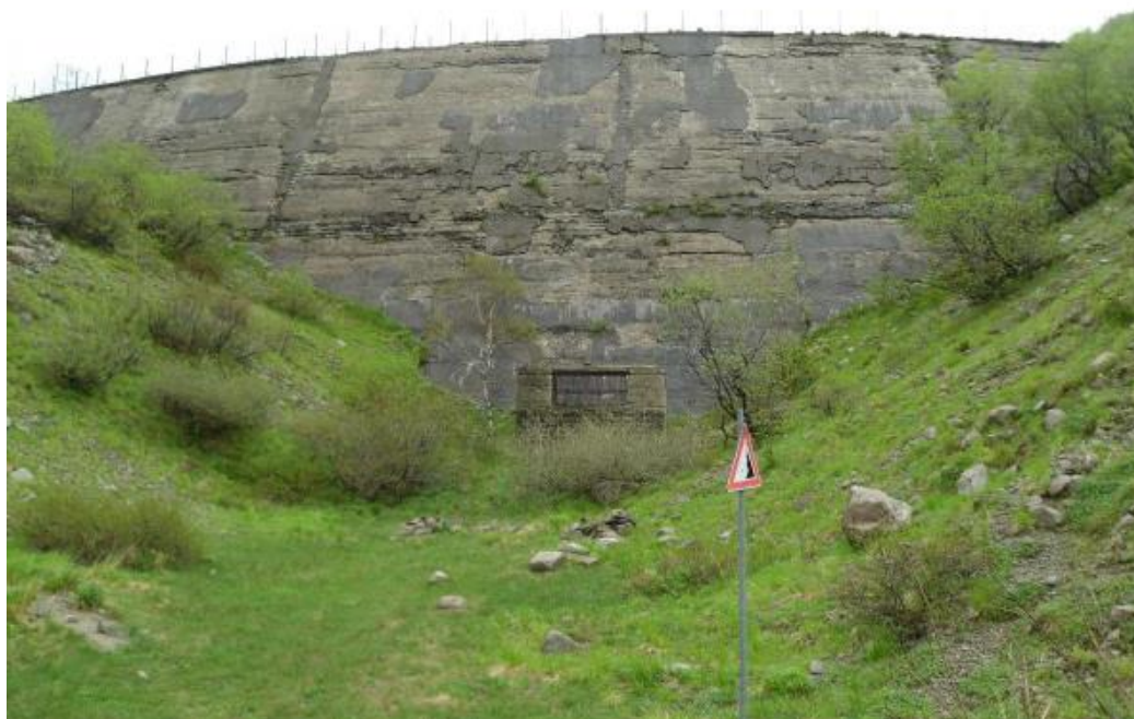
Figura 20 – Vista del paramento di monte dall'opera di presa
