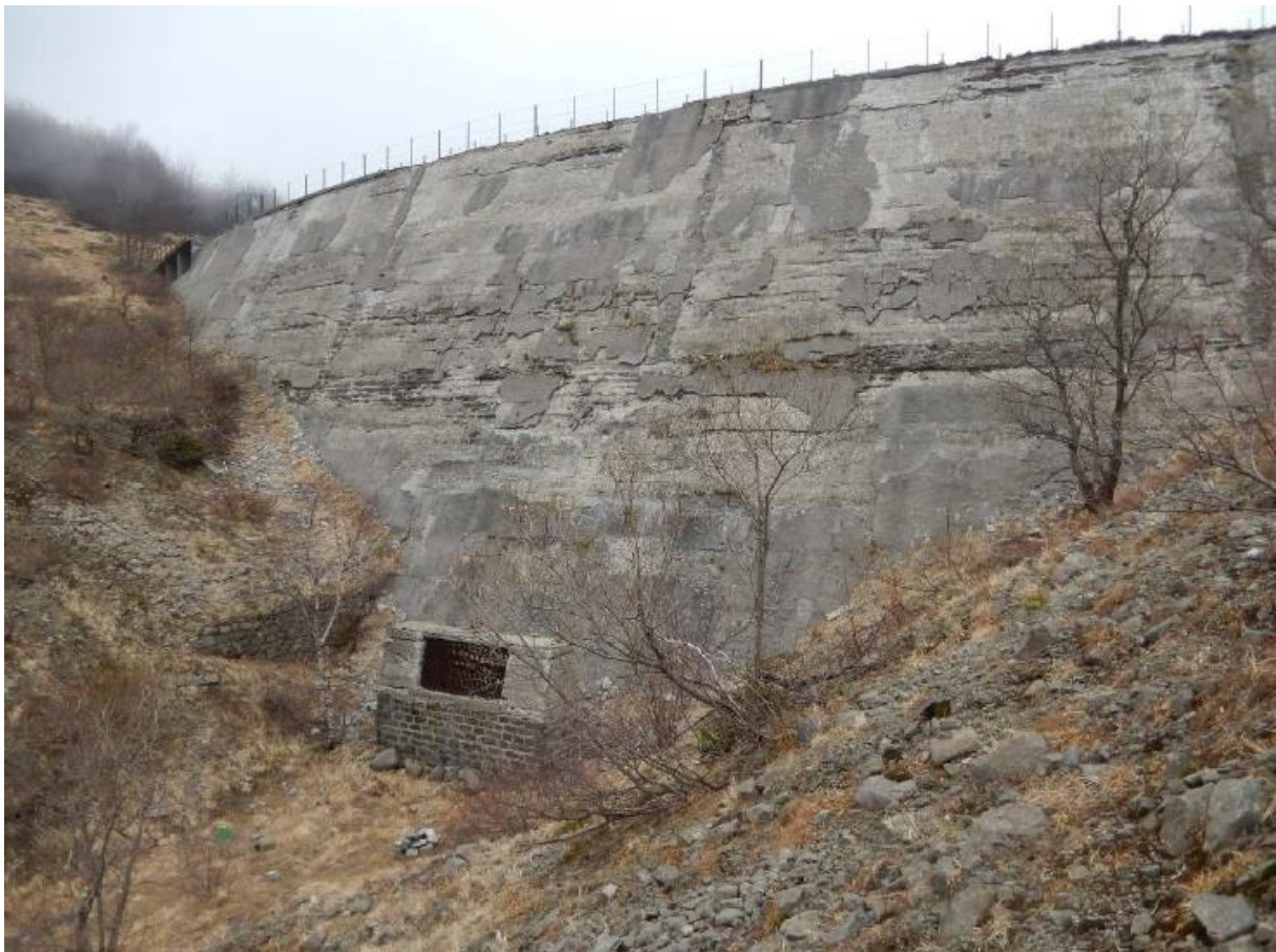
Figura 19 – Vista del paramento di monte dalla pista di accesso all'opera di presa
