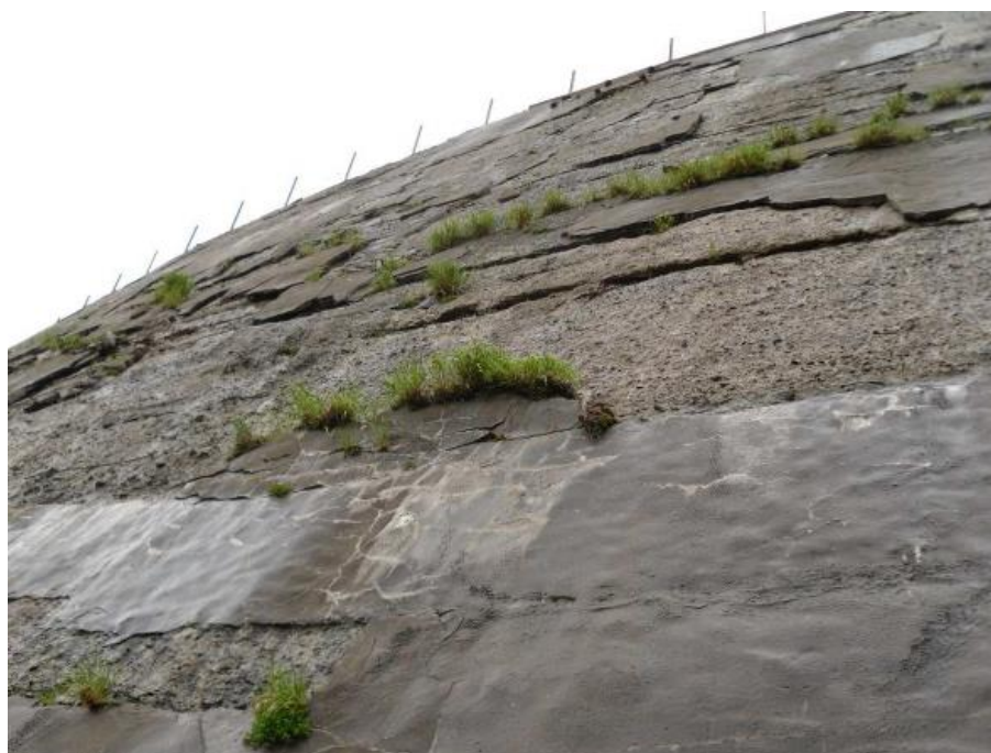
Figura 21 – Particolare del paramento di monte
