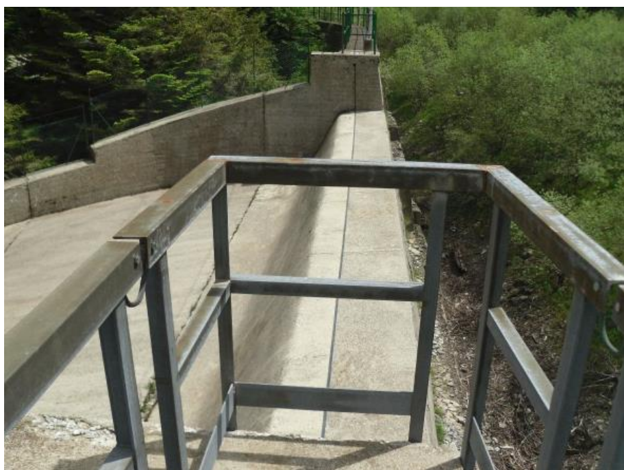
Figura 10 – Soglia dello scarico di superficie
