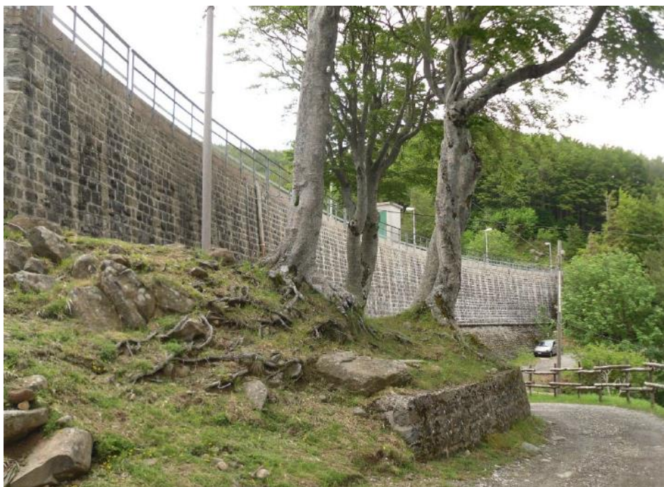
Figura 7 – Vista complessiva del paramento di valle della porzione curva dello sbarramento
