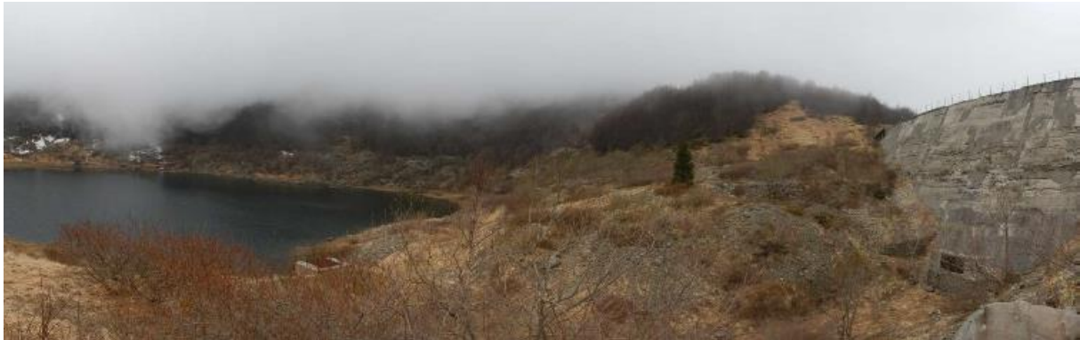
Figura 18 – Vista del paramento di monte e del lago naturale
