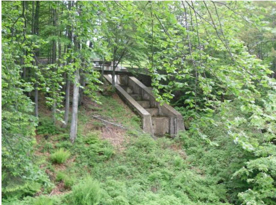
Figura 11 – Vista della porzione terminale del canale fuggatore dello scarico di superficie
