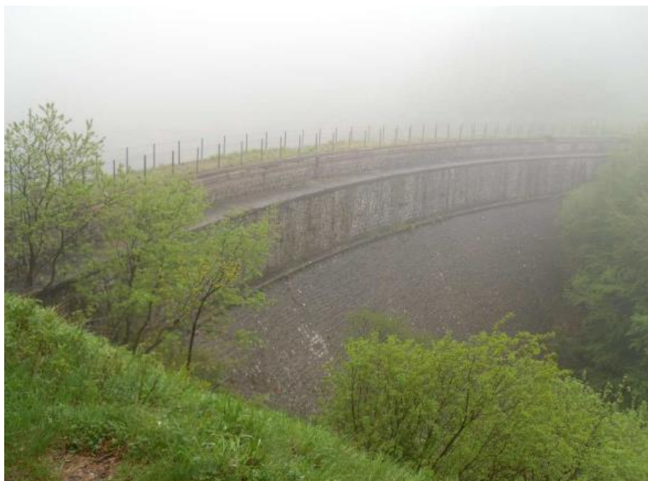
Figura 22 – Vista del paramento di valle dalla pista di accesso
