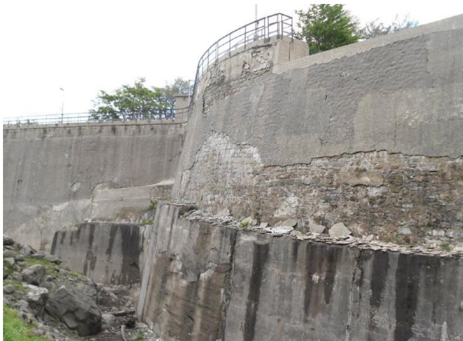
Figura 4 – Vista del paramento di monte in corrispondenza dello scarico di superficie
