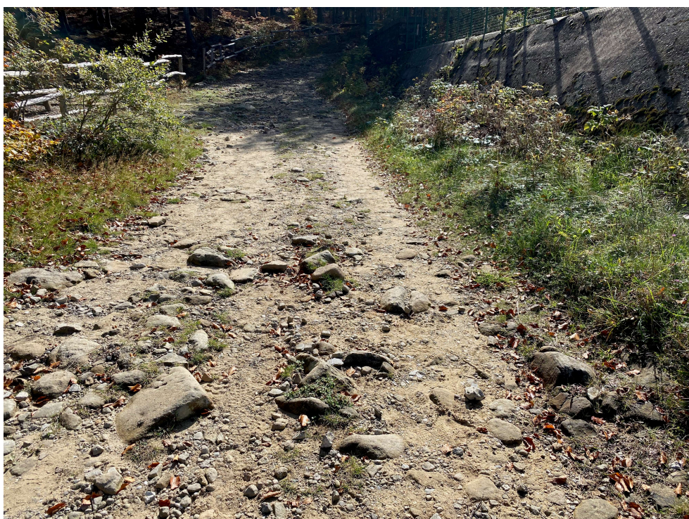
Strada carraia in pietrame (Sito 3)
