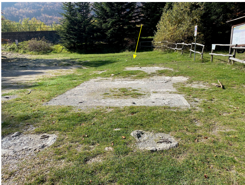
Cabinotto per gli attrezzi demolito la freccia indica il sito 2
