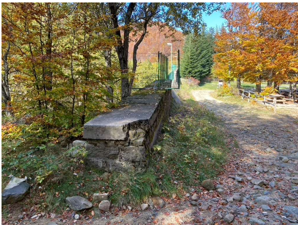
Muro di sbarramento della diga oggetto di demolizione a lato la carraia
