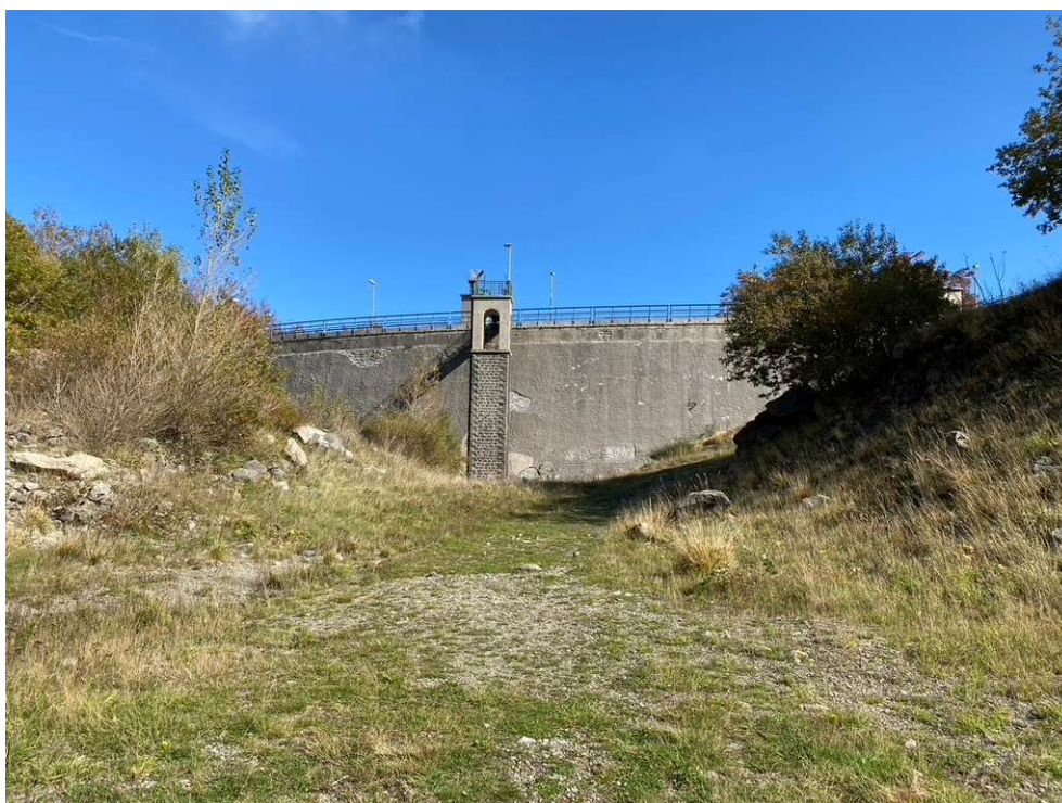
La diga visto da sud, il muro di sbarramento verrà parzialmente demolito
