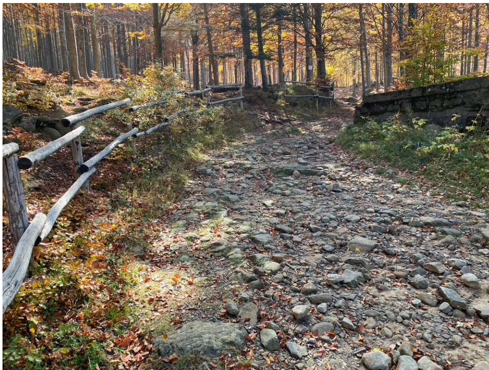
Strada carraia in pietrame
