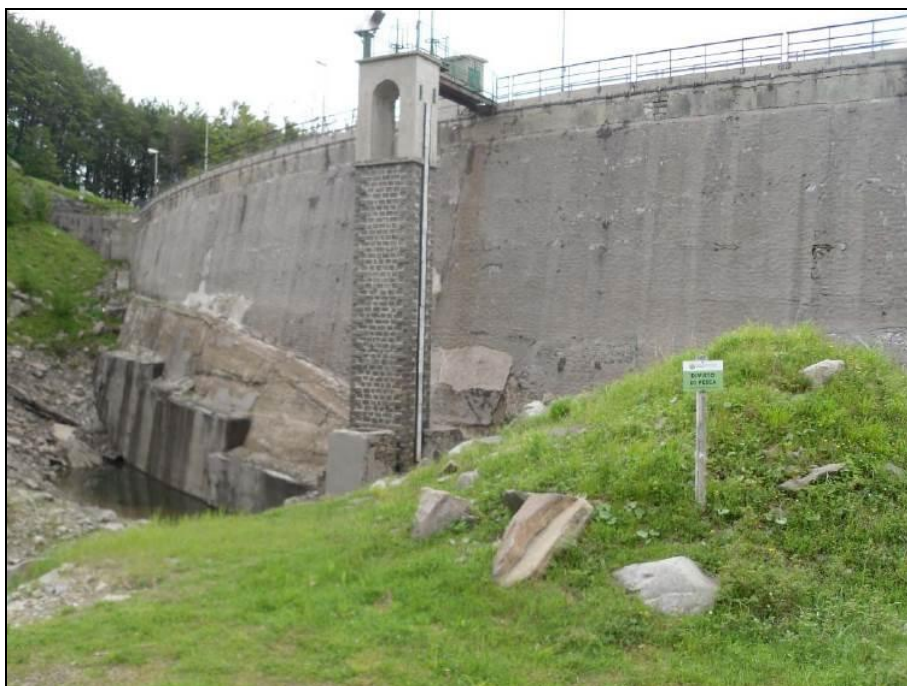
Figura 2-5 – Diga di lago Ballano – Vista del paramento di monte (Fonte: Relazione tecnico illustrativa - 2016)
