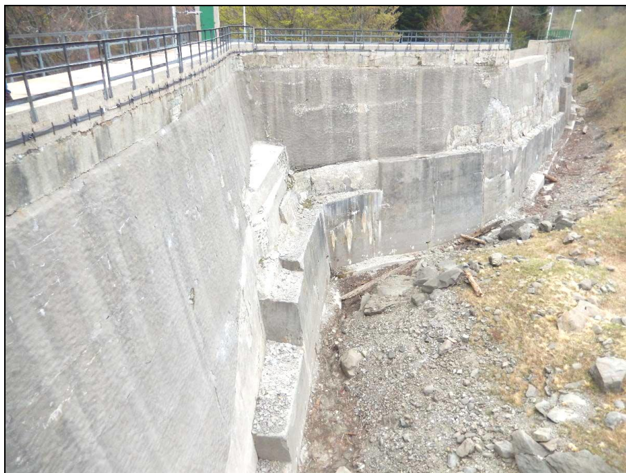
Figura 2-17: parametro di monte –sponda destra: dettaglio piede della diga (fonte: Relazione fotografica progetto)
