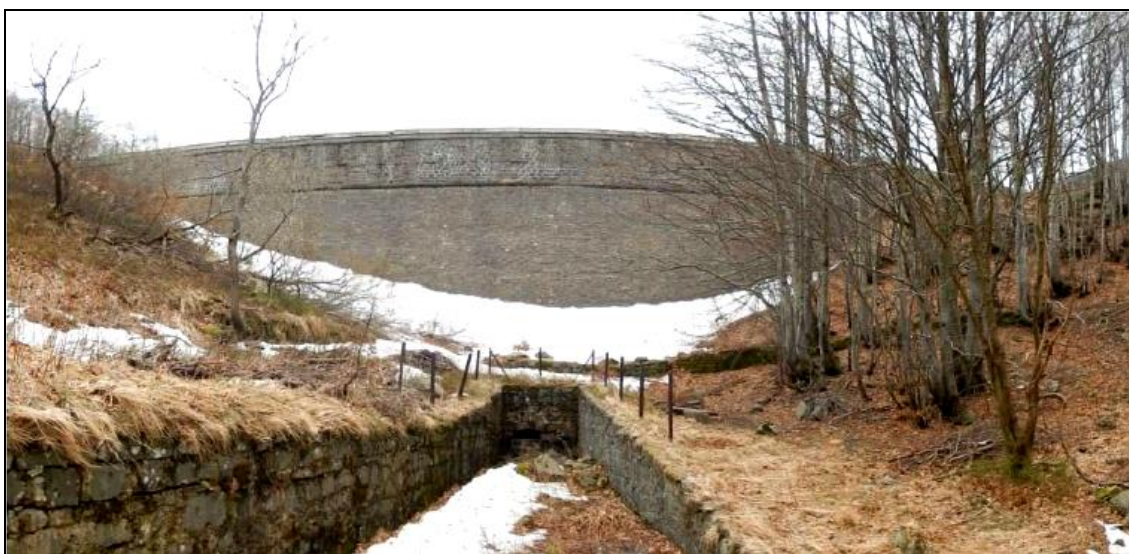
Figura 2-6 – Diga di lago Verde – Vista del paramento di valle (fonte: Relazione tecnico illust. - 2018)
