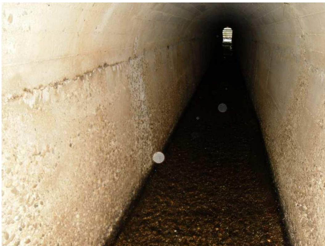
Figura 5-2 Il tratto di galleria che dall'opera di presa portava alla camera delle paratoie
