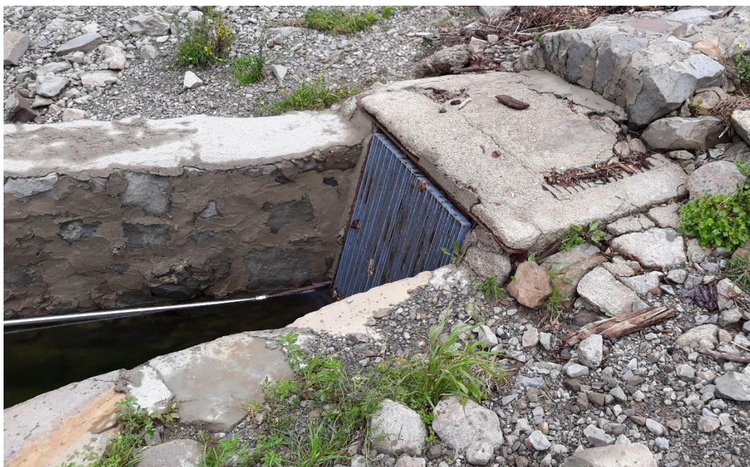
Figura 4-15 Imbocco dello scarico di fondo e opera di presa
