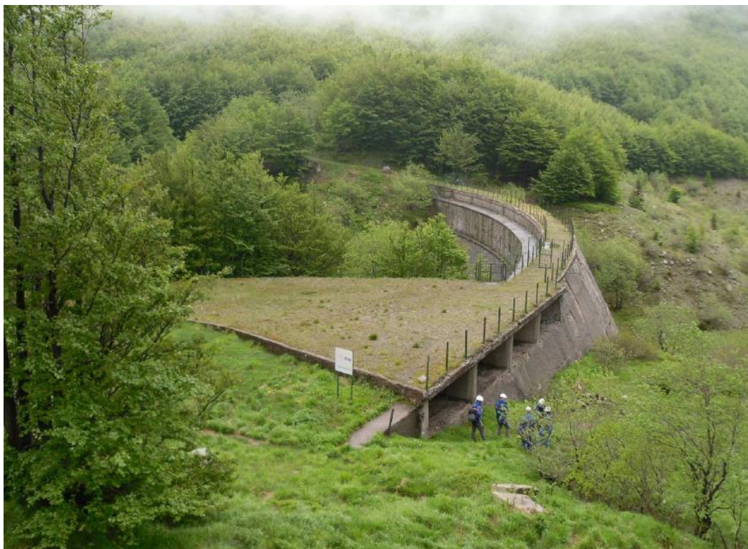
Figura 5-7 Vista della diga dal versante in sponda orografica sinistra + particolare imbocco scarico di superficie
