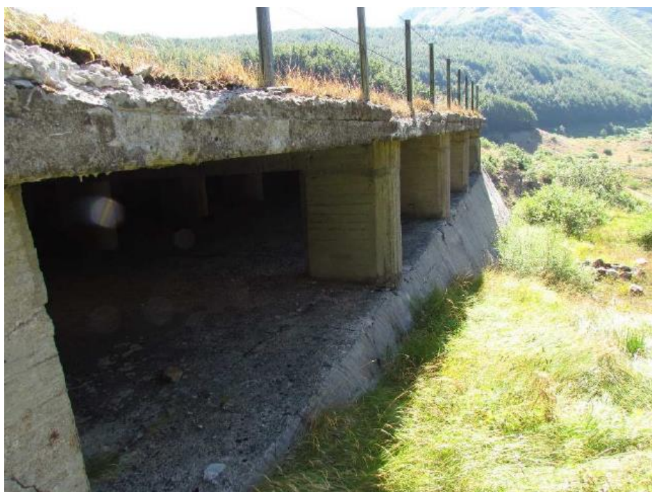
Figura 5-15 – Soglia dello sfioratore attuale
