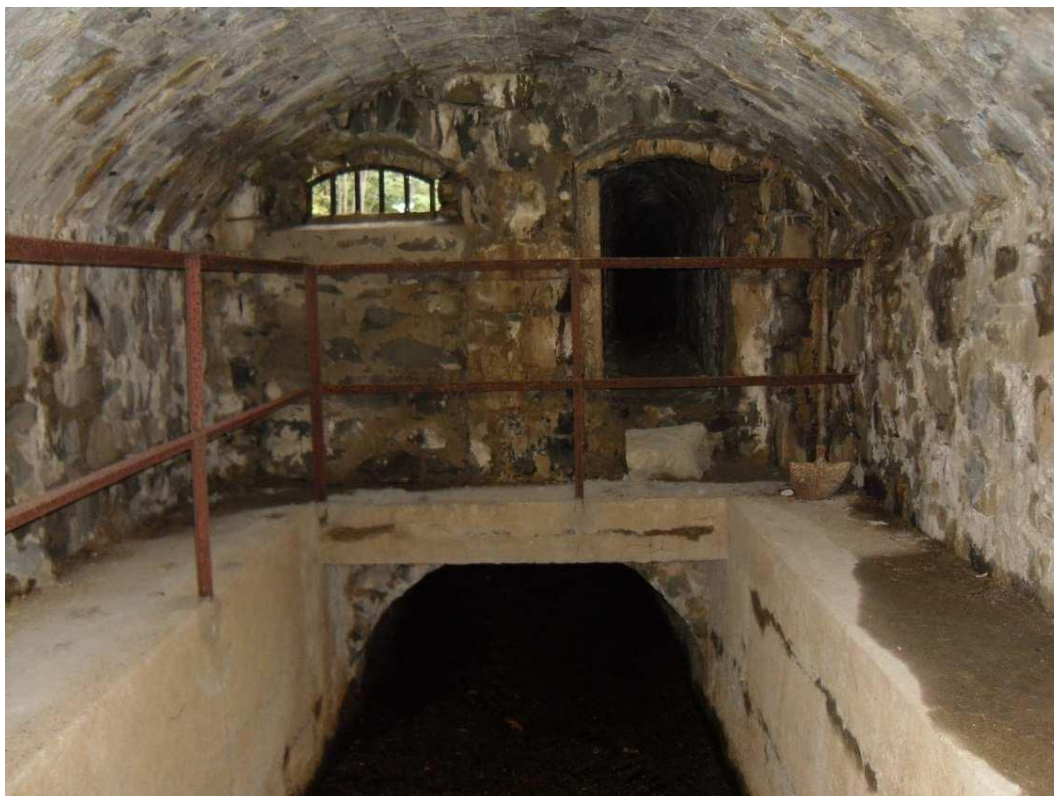
Figura 5-5 Il vano dove scaricano le due tubazioni metalliche dello scarico di fondo
