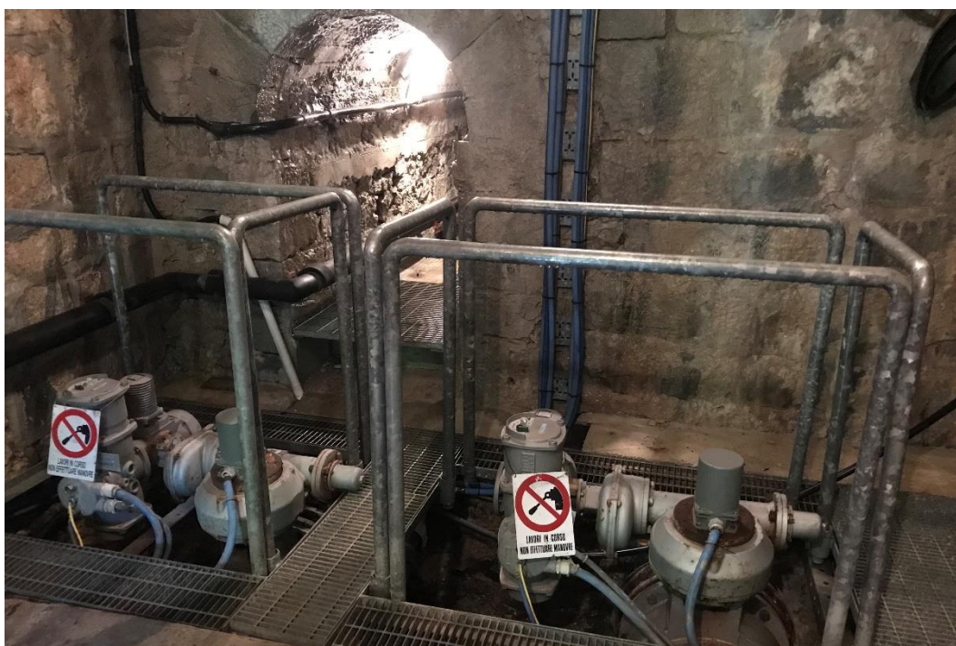
Figura 4-17 Camera di manovra
