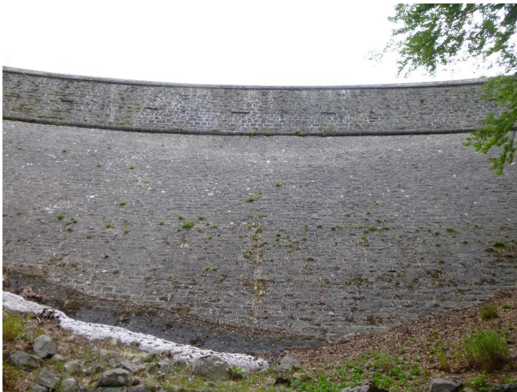
Figura 5-13 – Stato del paramento di valle
