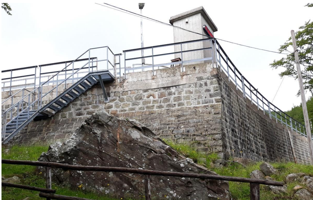
Figura 4-12 Paramento di valle della diga
