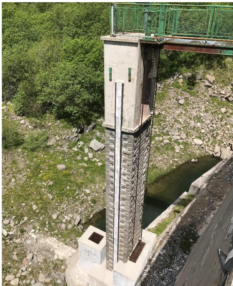
Figura 4-16 Torre di manovra
