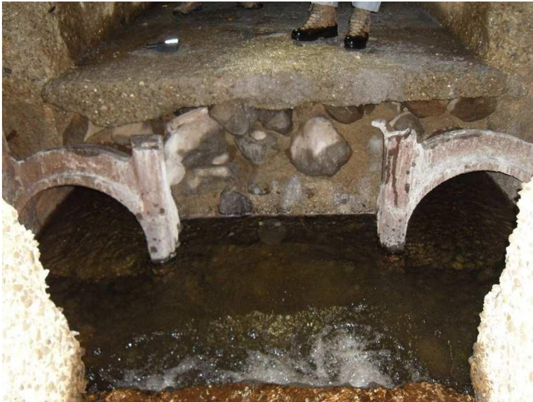
Figura 5-3 Le tubazioni che fungevano da scarico di fondo
