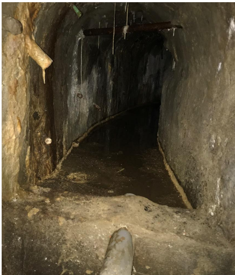
Figura 4-18 Galleria di drenaggio
