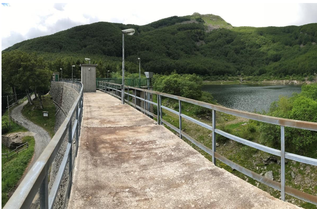
Figura 4-11 Coronamento della diga
