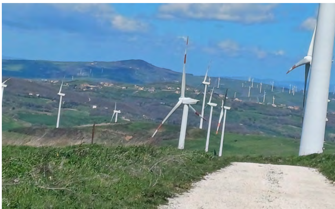
Fig. 2. Vista dell'impianto esistente e le attuali condizioni del territorio
