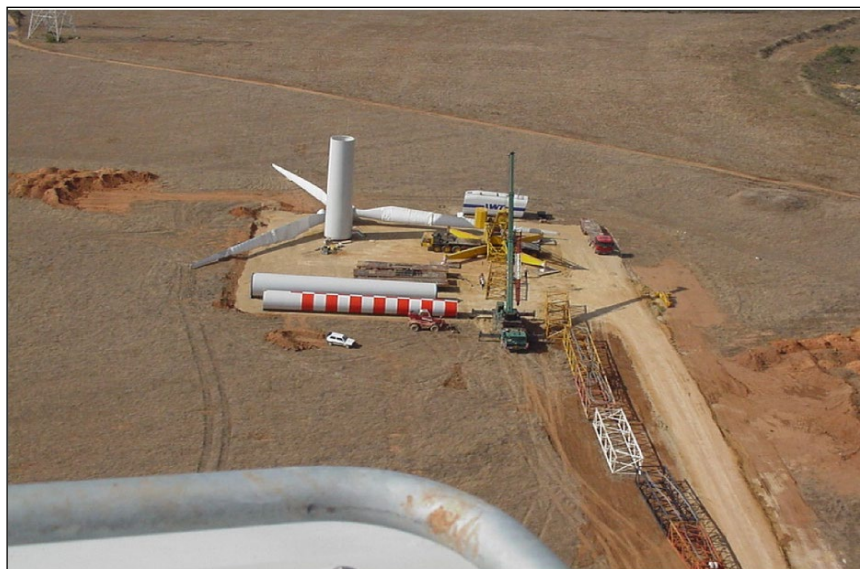
Foto 1. Piazzola per il montaggio dell'aerogeneratore
