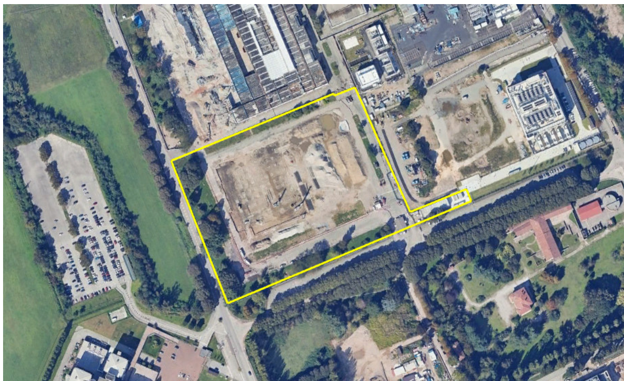
Figura 2.1 – Area sulla quale è in corso la realizzazione del Data Center MXP2 - Comune di Settimo M.se
