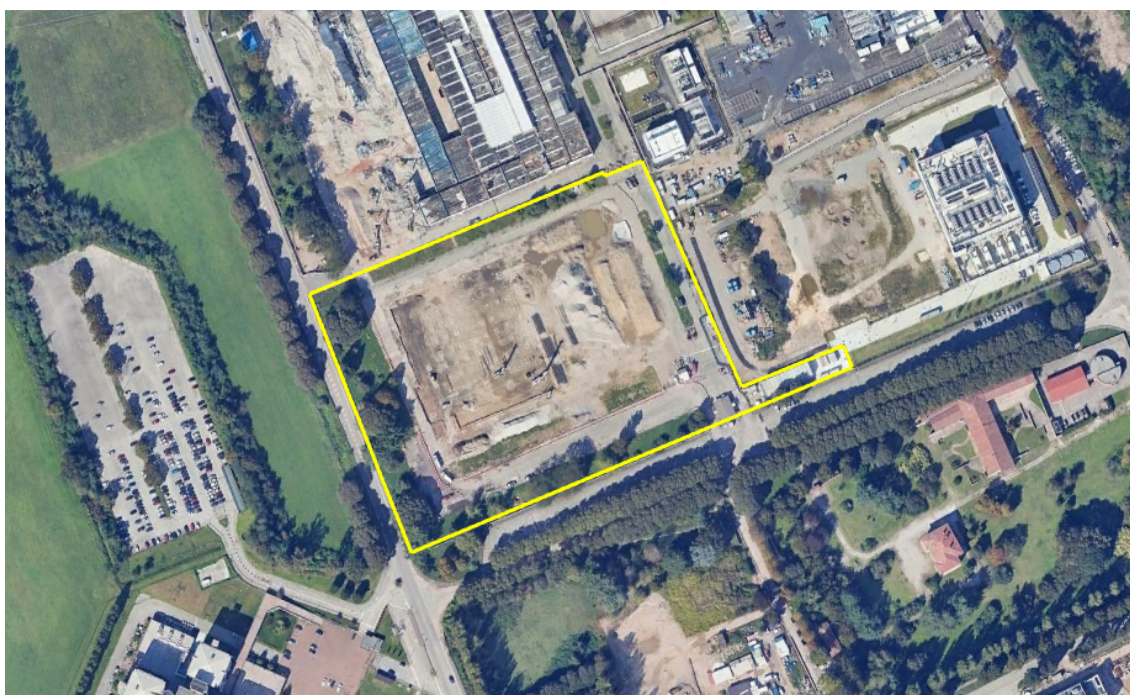
Figura 2.1 – Area sulla quale è in via di realizzazione del Data Center MXP2 - Comune di Settimo M.se
