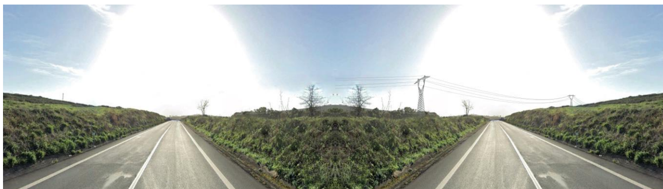
Figura 7 – Stralcio da RS06AEG0021A1 Foto a Volo d’uccello, Skyline e Render fotografici – tralicci dell’elettrodotto aereo a sinistra la strada panoramica SS194 a destra con i tralicci e l’elettrodotto
