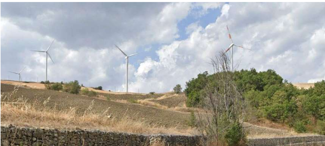
11- report fotografico dello stato di fatto
