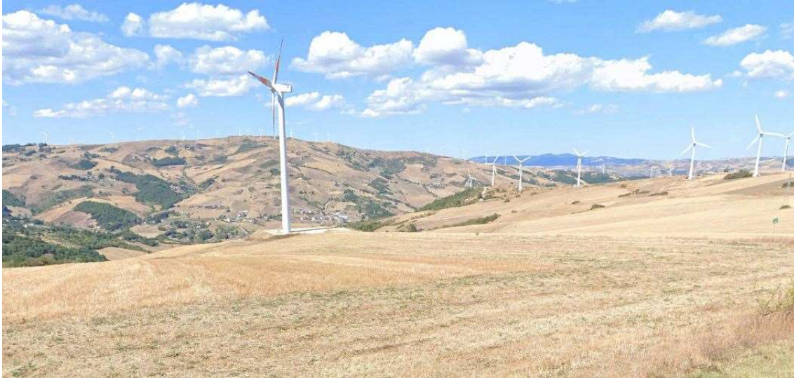
9- report fotografico dello stato di fatto
