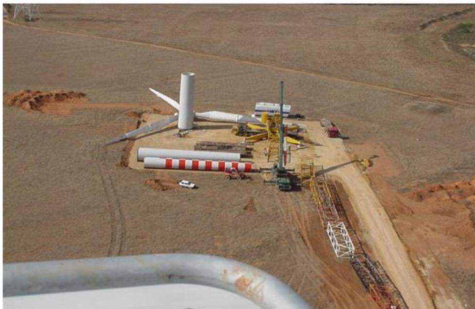
Esempio costruzione piazzola per il montaggio della torre eolica
