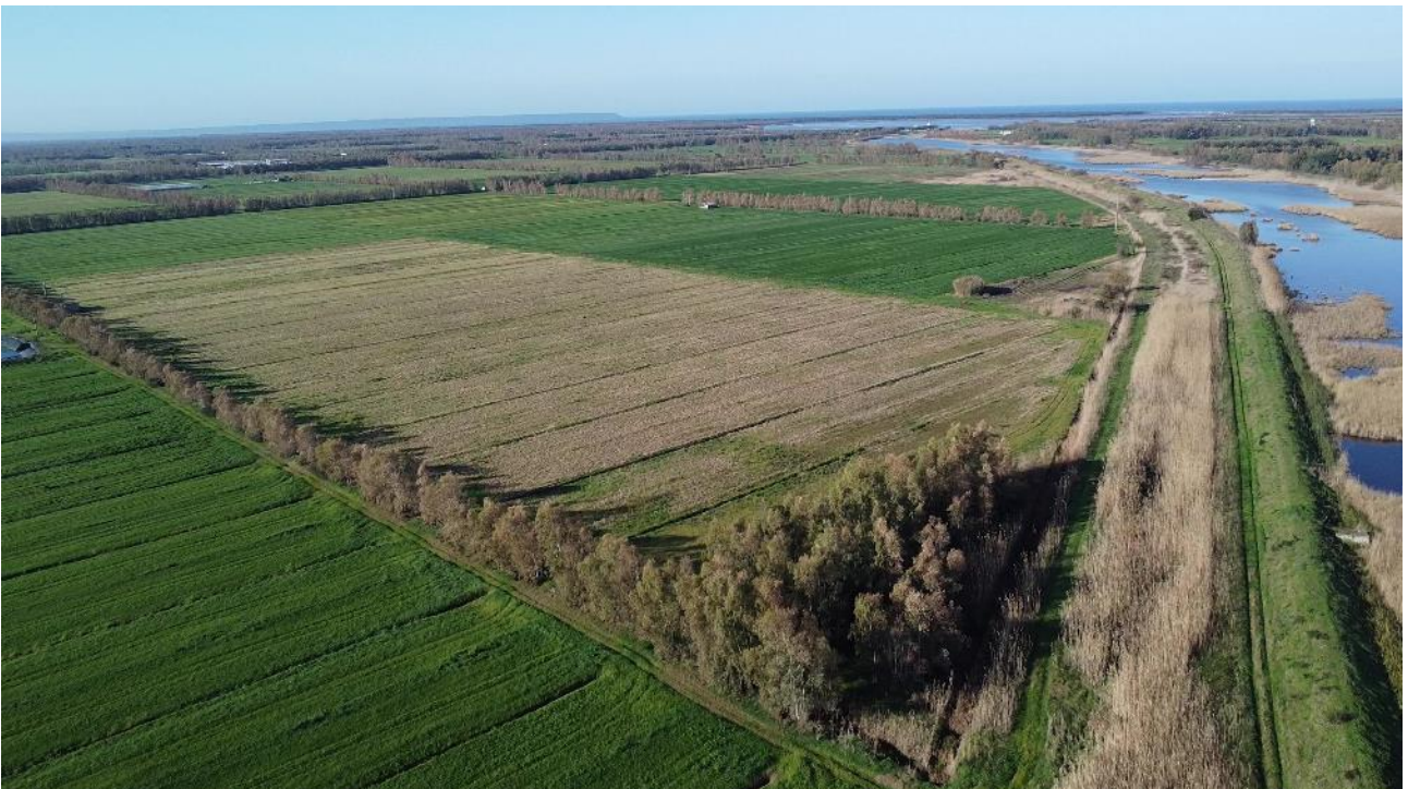
Figura 60 –vista aerea della parte ovest dell’impianto
