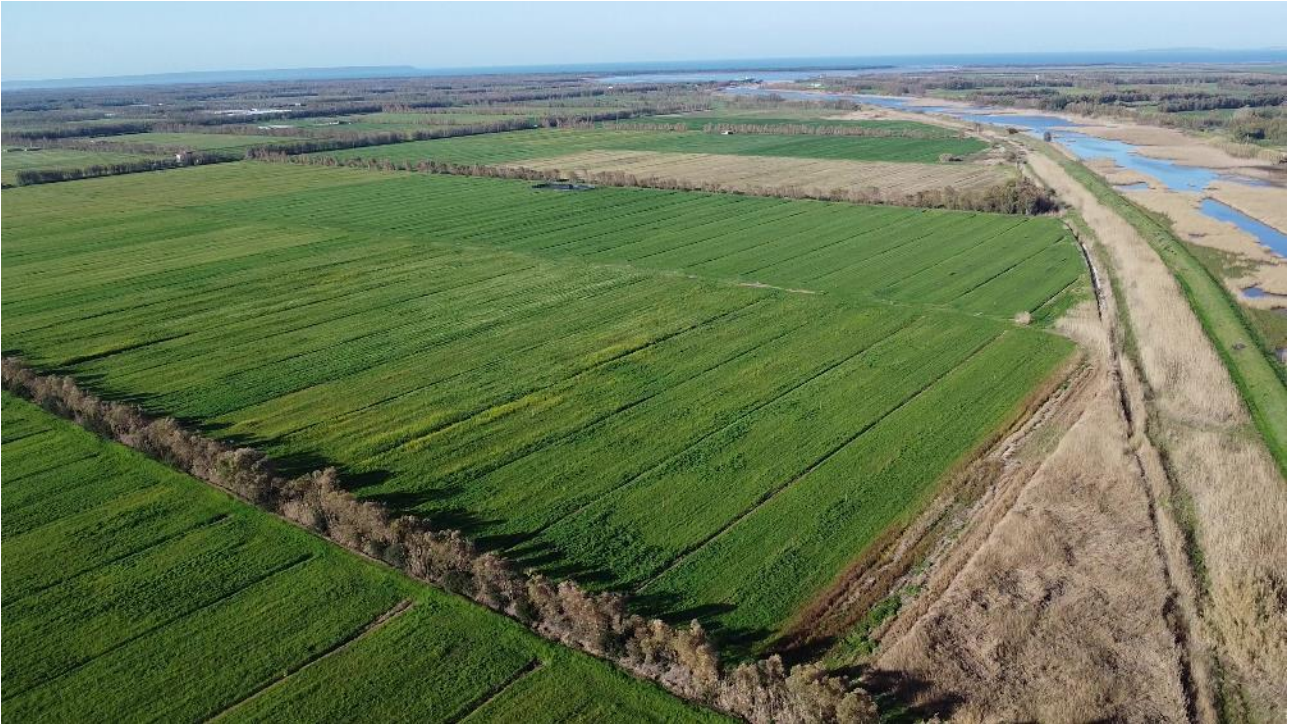
Figura 61 –vista aerea della parte centrale dell’impianto
