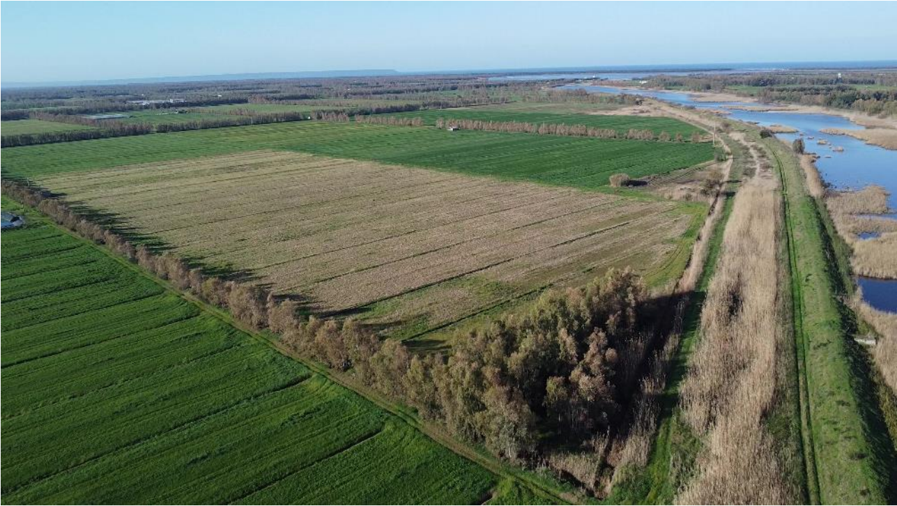
Figura 78 –vista aerea della parte ovest dell’impianto
