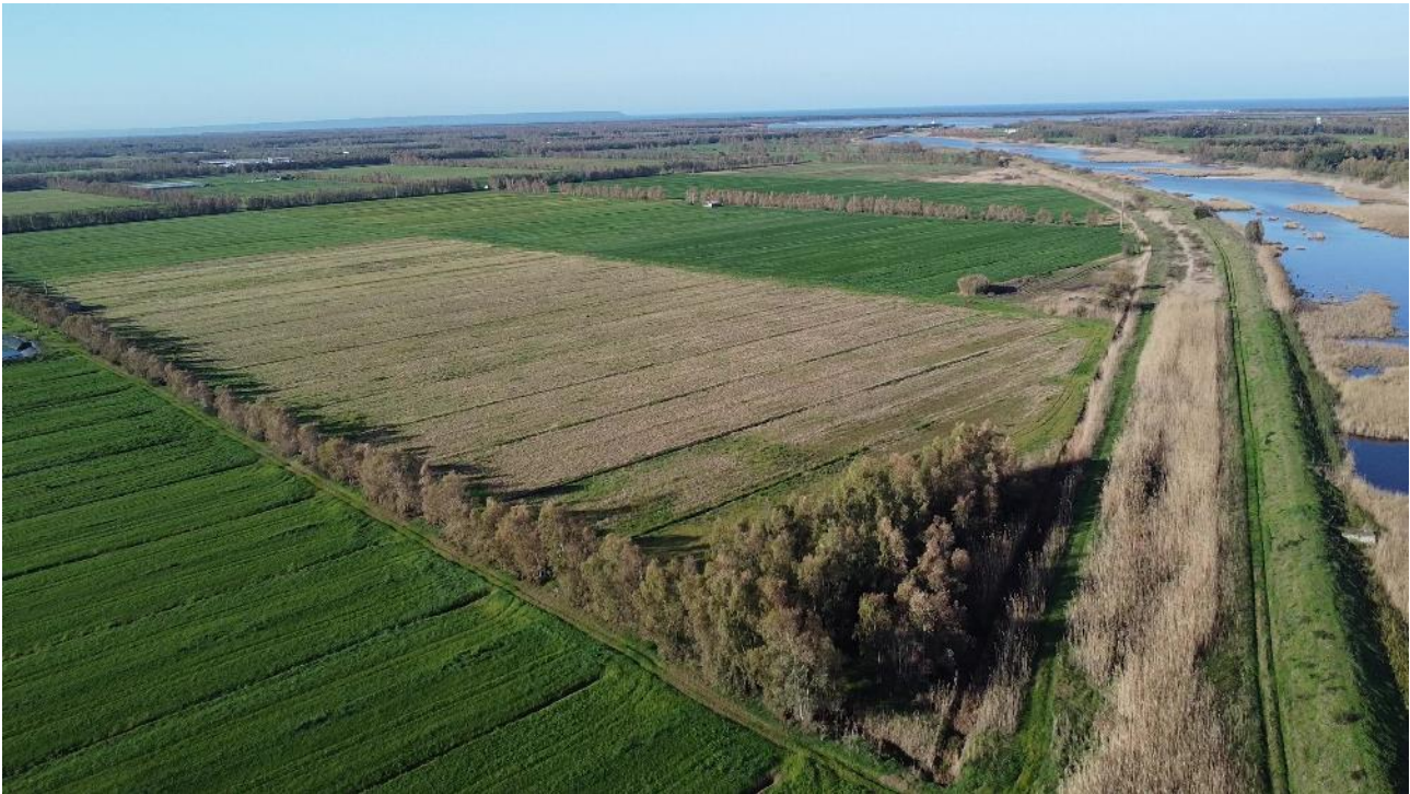
Figura 26 –vista aerea della parte ovest dell'impianto
