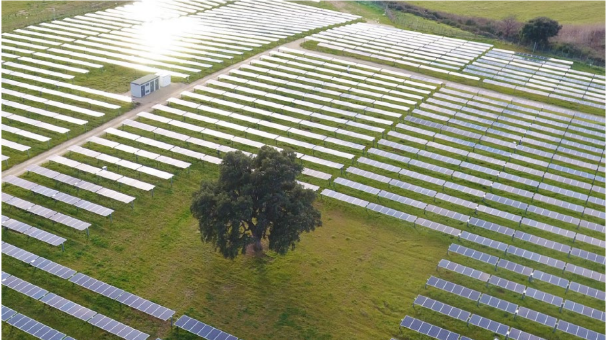
Figura 7 – esempio di impianto realizzato con i tracker proposti e pannelli in configurazione monofilare
