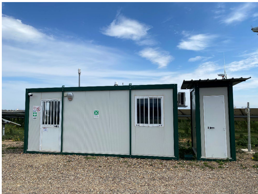
Immagine 3.3: control room e wc chimico
