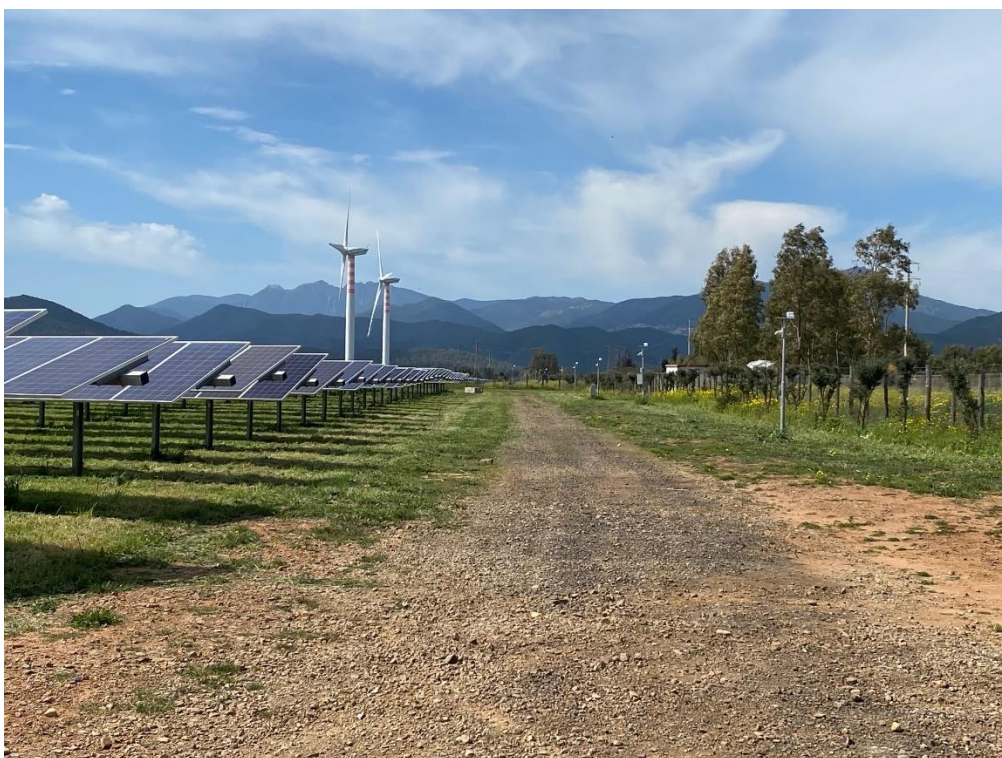
Figure 5-6 – impianti con viabilità interna
