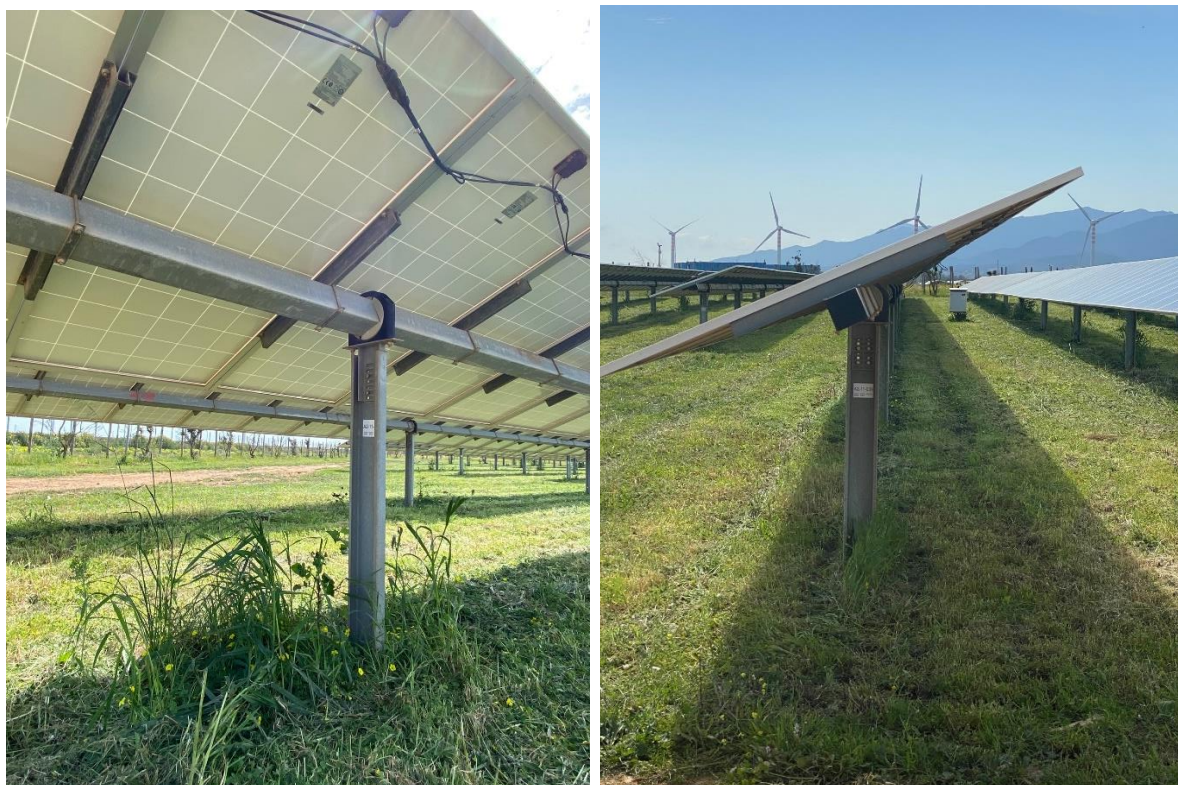
Figure 3-4 – Rappresentazione tipo della struttura di supporto
