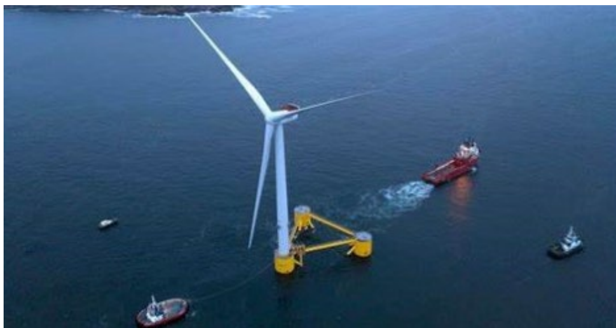
Figura 7-6: Traino a mare dal cantiere di fabbricazione al sito di integrazione.
