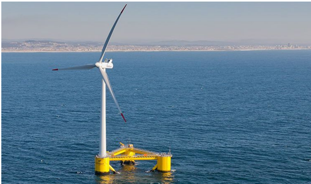
Figura 5-11: Esempio di fondazione galleggiante di colore giallo.
