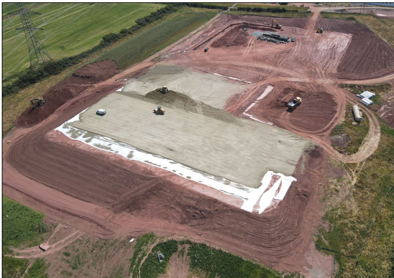
Figura 2-39: Attività di preparazione delle aree di cantiere.
