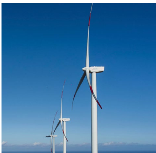
Figura 2-3: Esempio aerogeneratori visibilità diurna con bande rosse e bianche.
