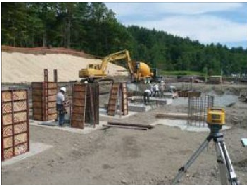
Figura 2-41: Opere di fondazione in calcestruzzo.
