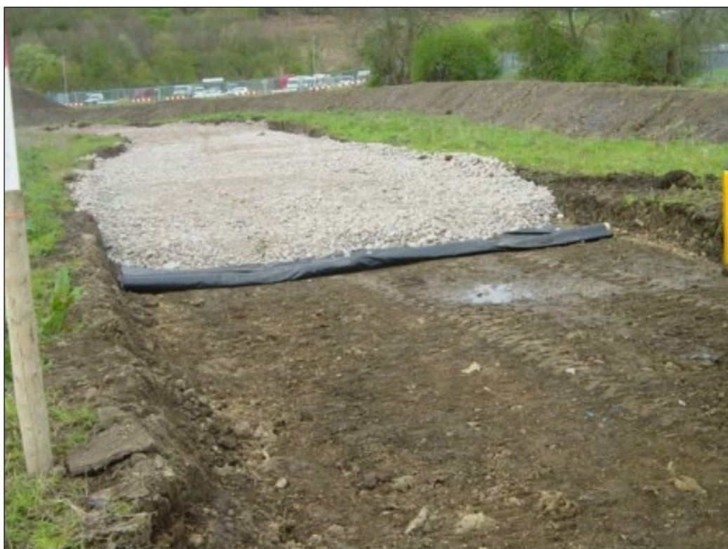
Figura 2-40: Esempio di costruzione della strada di accesso mediante misto stabilizzato.
