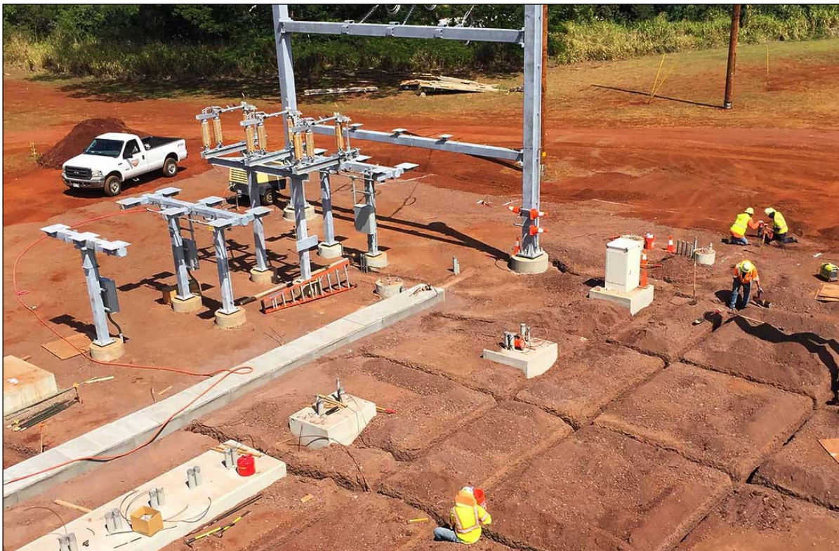
Figura 2-38: Attività di collegamenti alla rete di messa a terra della sottostazione.
