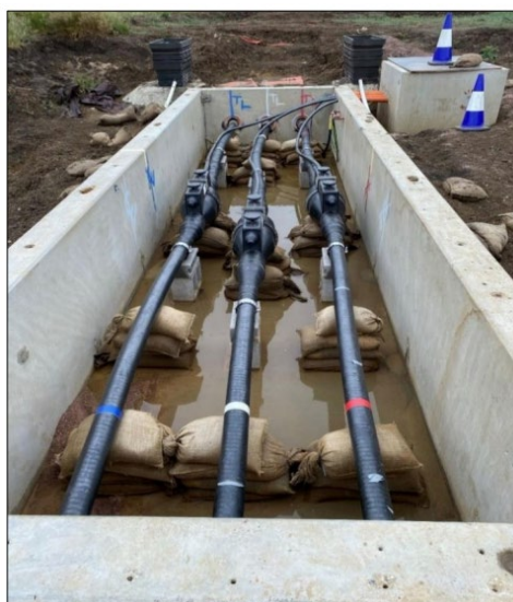
Figura 2-14: Esempio di buca giunti terra-mare (buca giunti).
