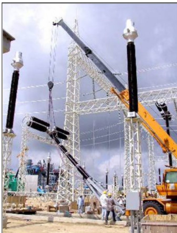
Figura 2-44: Cantiere di una sottostazione elettrica.
