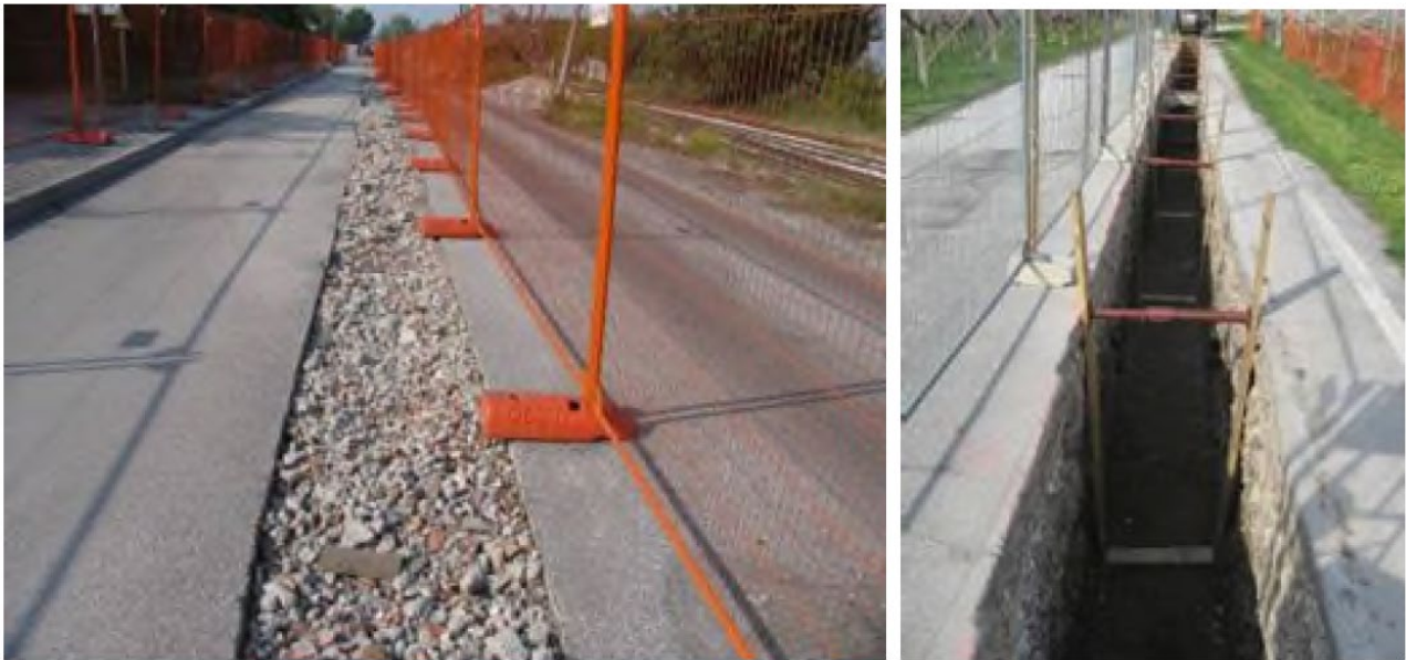
Figura 2-23: Taglio dell'asfaltatura e scavo aperto.
