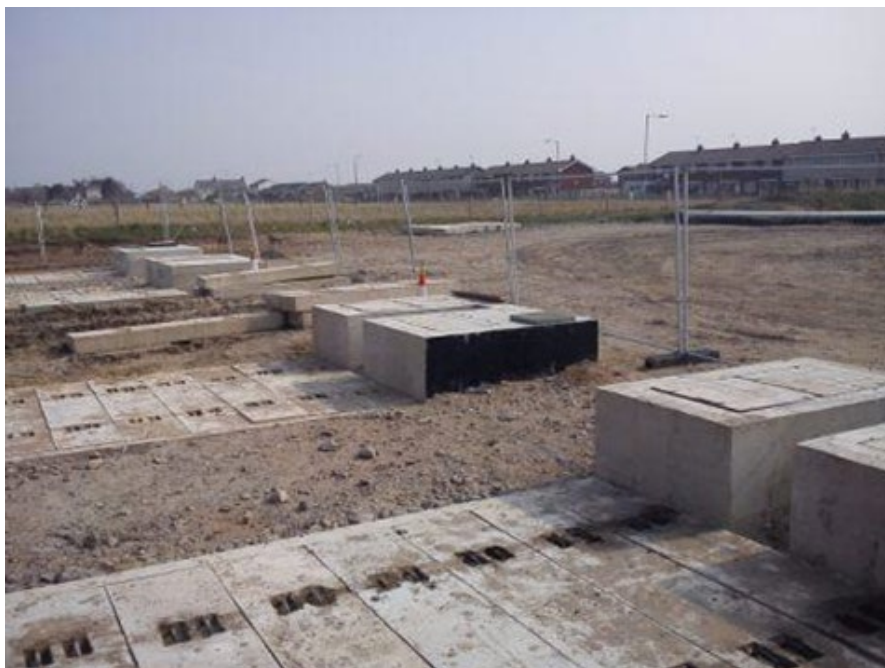
Figura 2-18: Foto esemplificativa chiusura buca giunti Terra-Mare, prima del riporto di terreno vegetale 5 .
