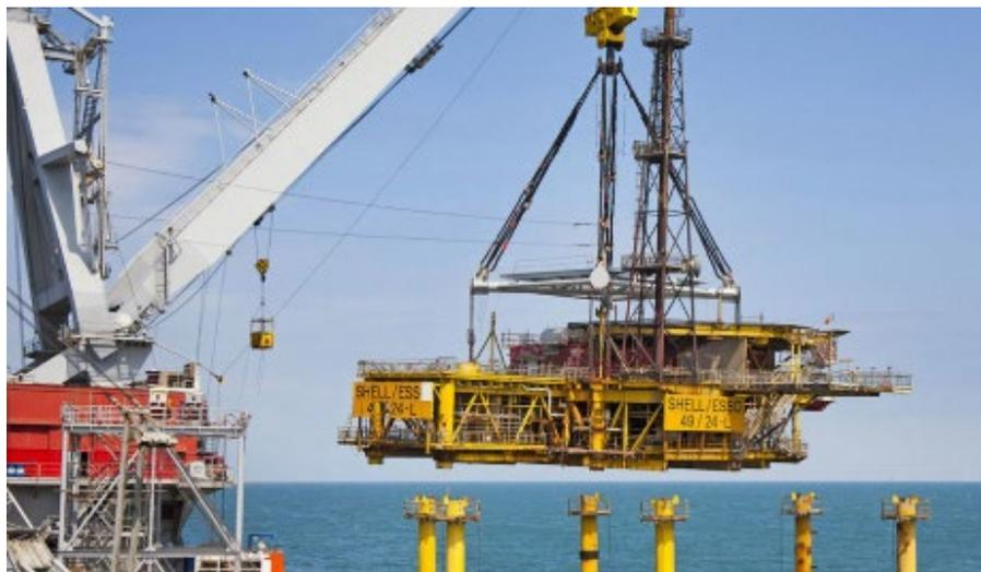
Figura 4-1: Una nave per il sollevamento di carichi pesanti solleva il lato superiore della piattaforma petrolifera.
