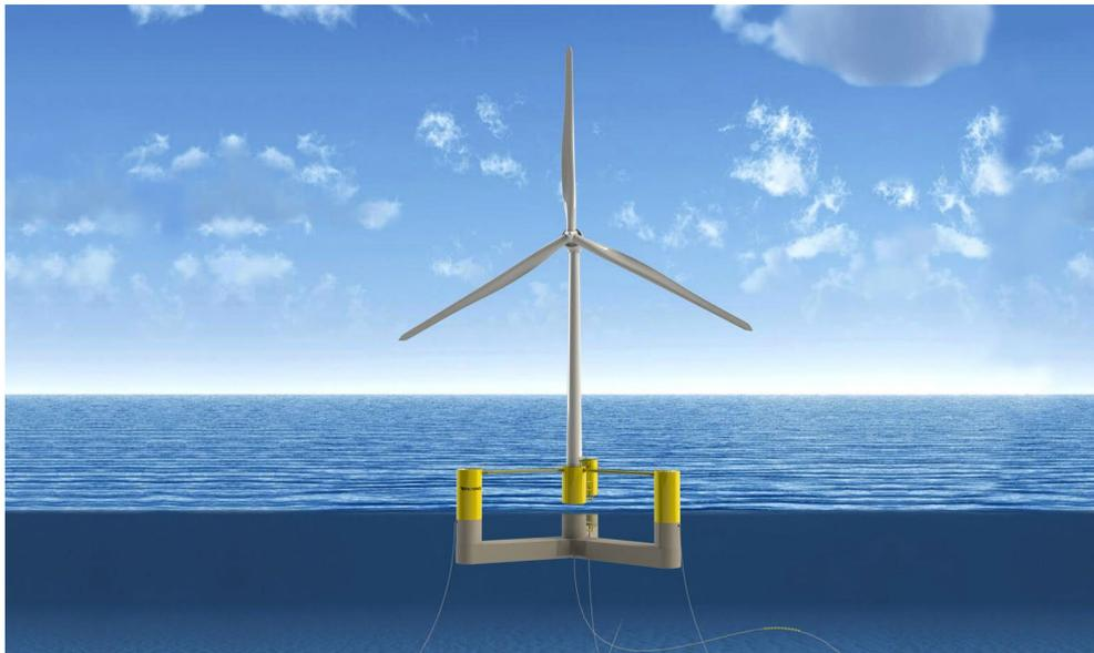
Figura 9-2. Tipologico di un Galleggiante VoltturnUS-S,
