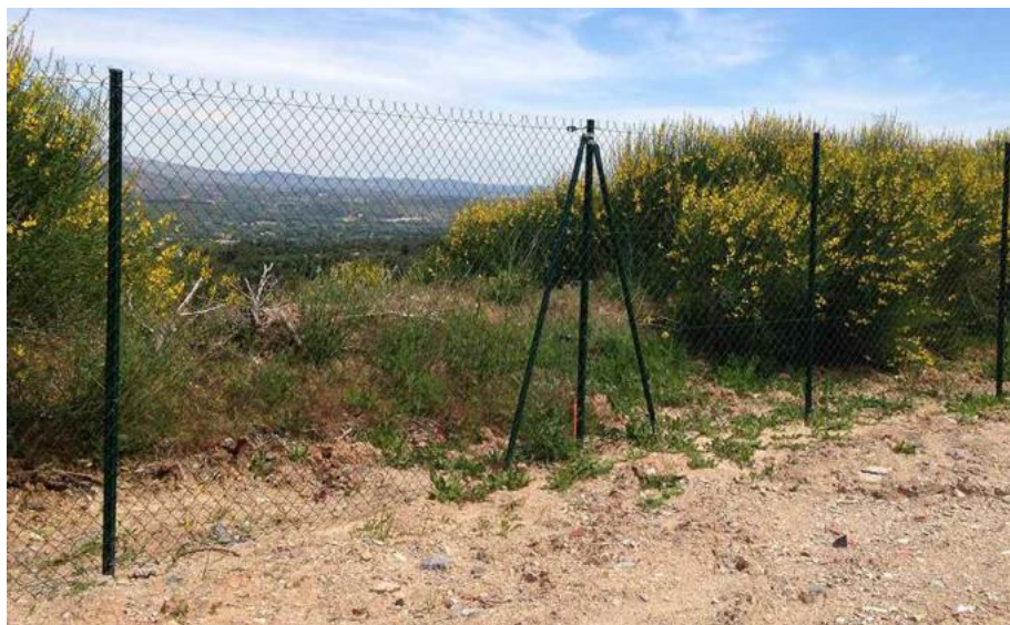
Figura 61: Esempio rappresentativo della recinzione dell'area buca giunti terra-mare.
