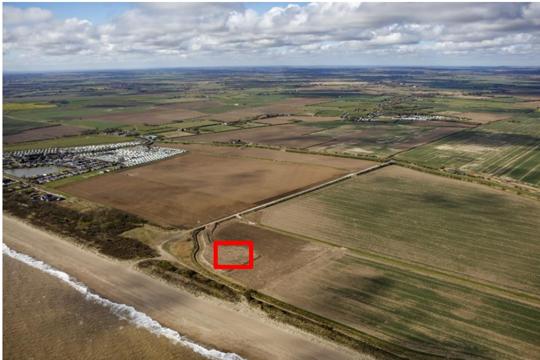
Figura 64: Foto esemplificativa chiusura buca giunti Terra-mare, dopo il riporto di terreno vegetale (Fonte OWC - ABL Group). Nel quadrato rosso sono localizzati i tombini delle buche giunti terra-mare.
