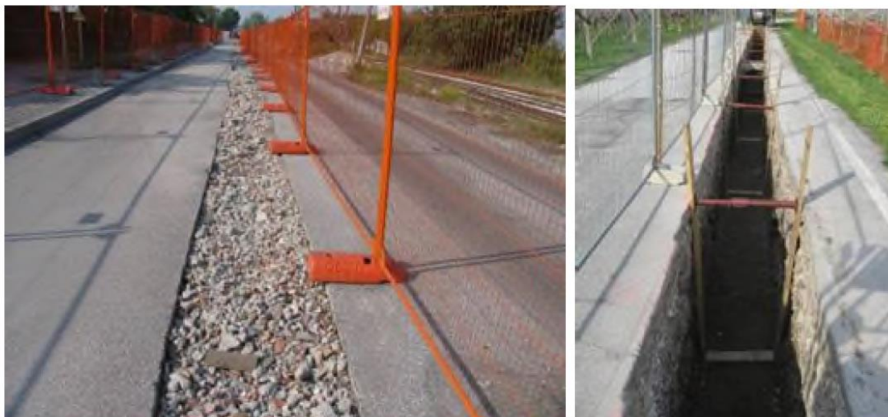
Figura 67: Taglio dell'asfaltatura e scavo aperto.
