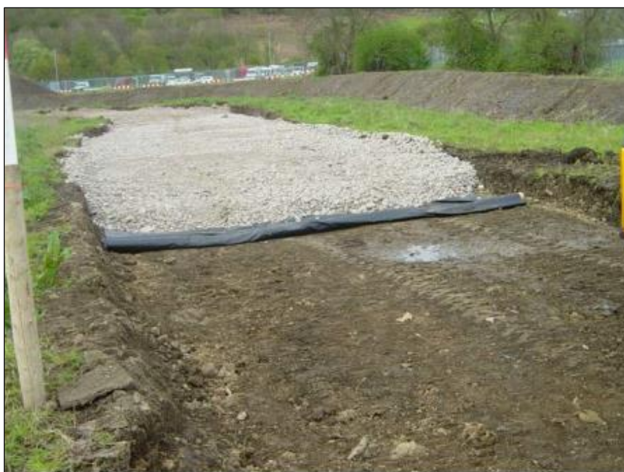
Figura 83: Esempio di costruzione della strada di accesso.
