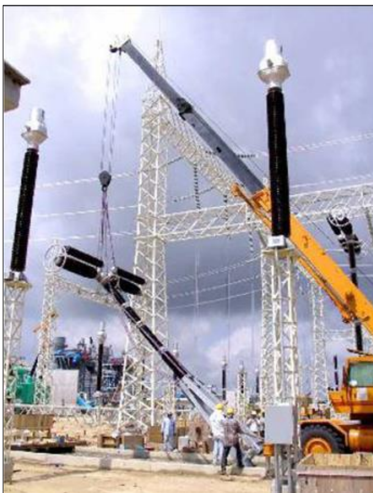
Figura 85: Cantiere di una stazione elettrica.
