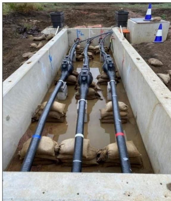
Figura 40: Esempio di buca giunti terra-mare (buca giunti).
