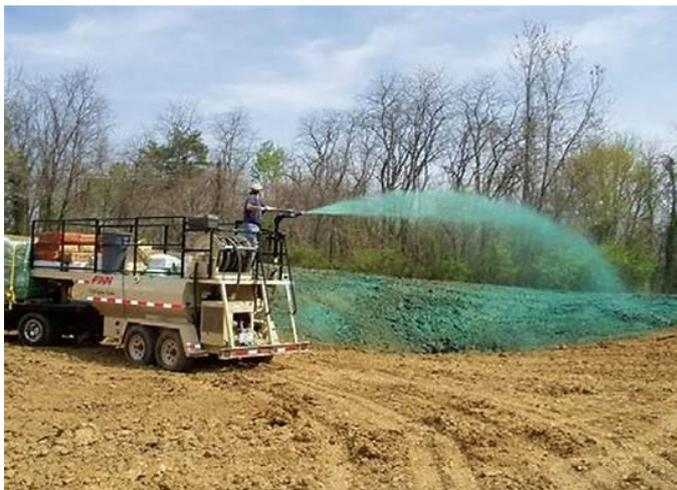
**Figura 23: Idrosemina su terra pieni di mascheramento della Stazione Elettrica**
