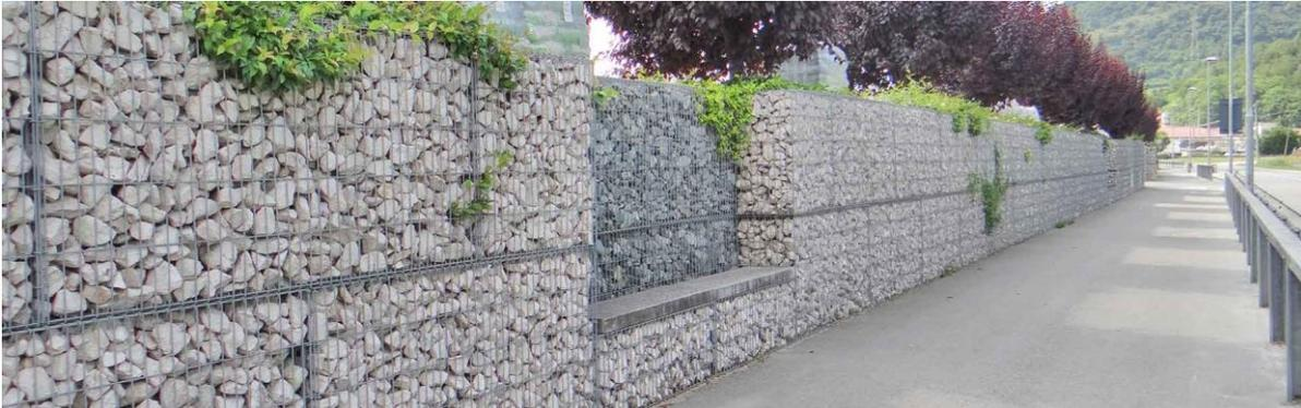
**Figura 21: Tipico di recinzione con muro in gabbione armato e sassi (fonte: OW.ITA-SAR-GEN-OWC-ENV-DWG-56A).**
