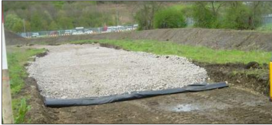
Figura 36: Esempio di costruzione della strada di accesso.
