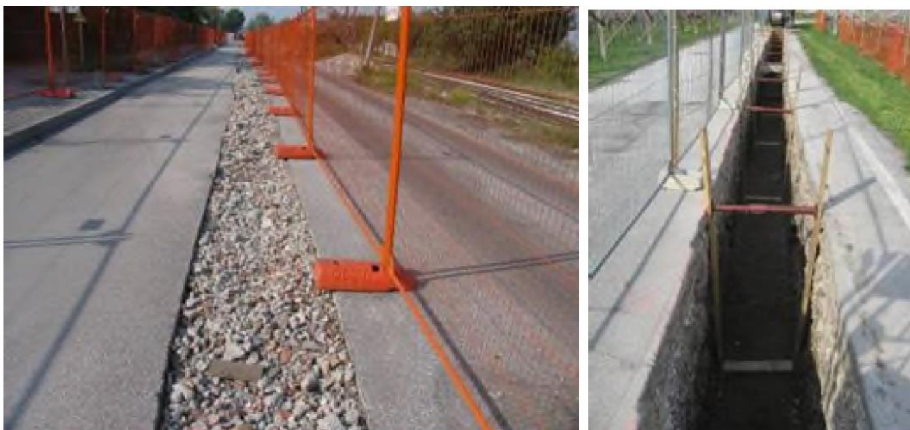
Figura 33: Taglio dell'asfaltatura e scavo aperto.
