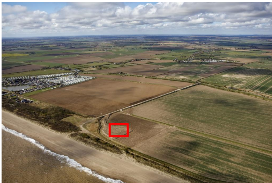
Figura 31: Foto esemplificativa chiusura buca giunti Terra-mare, dopo il riporto di terreno vegetale (Fonte OWC - ABL Group). Nel quadrato rosso sono localizzati i tombini delle buche giunti Terra-Mare
