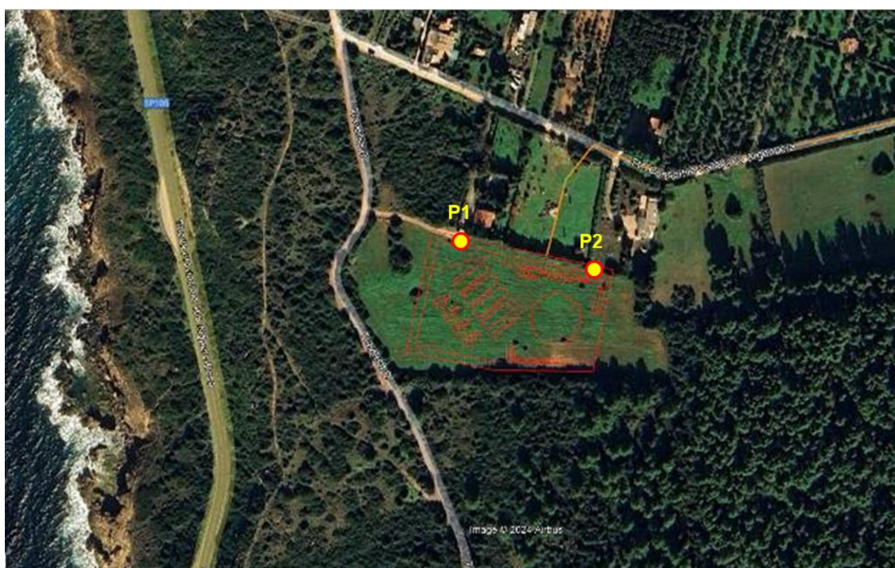
Figura 20: Punti di misura fonometrica ante operam P1÷P2 pressi buca giunti di transizione marino-terrestre
