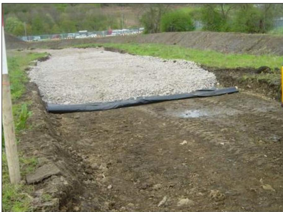
**Figura 56: Esempio di costruzione della strada di accesso.**
