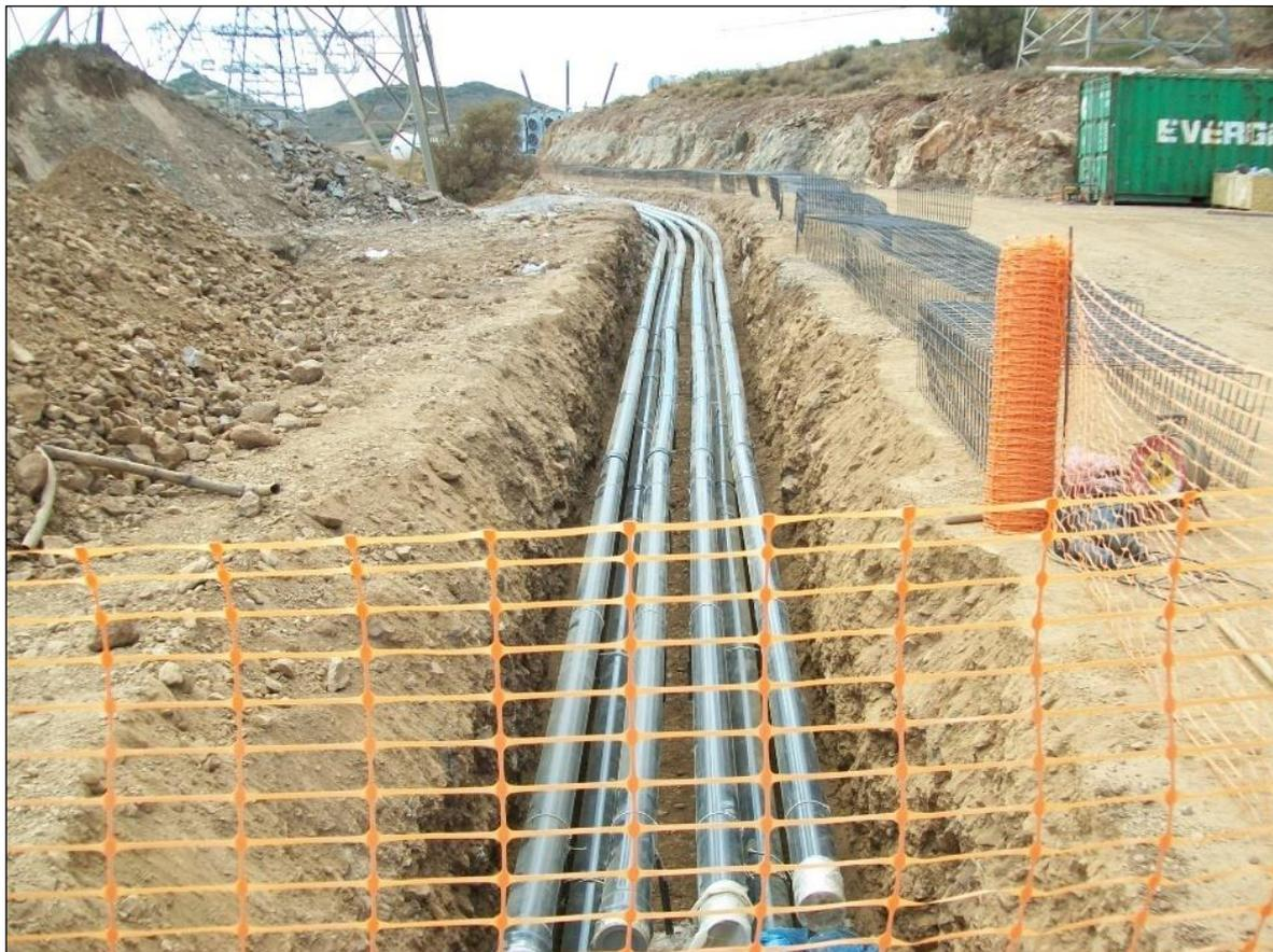
**Figura 57: Tipologico di Posa dei cavi in prossimità di Stazioni Elettriche**
