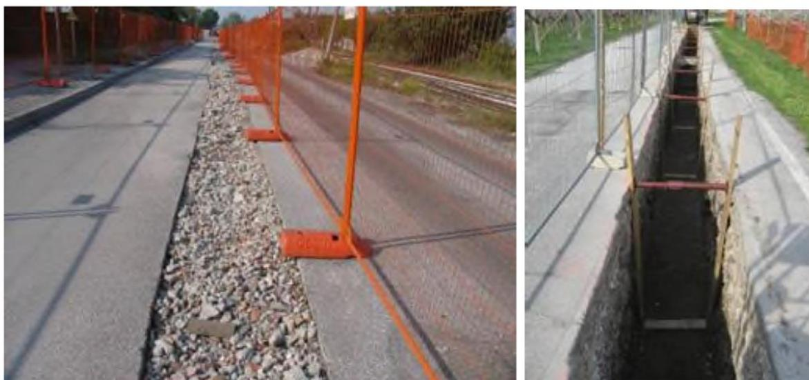
**Figura 42: Taglio dell'asfaltatura e scavo aperto**
