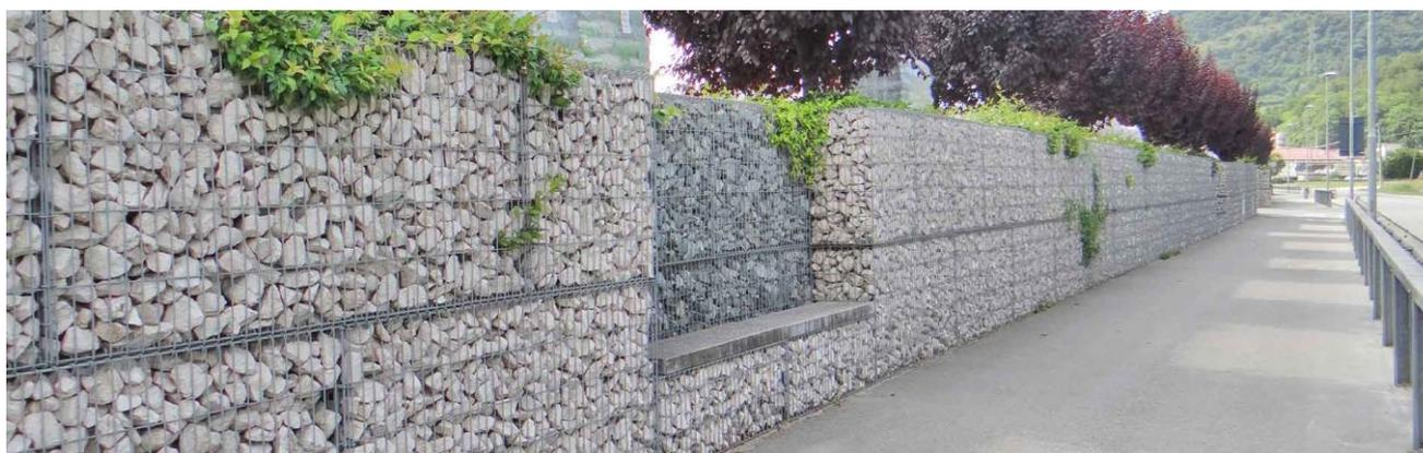
**Figura 22: Tipico di recinzione con muro in gabbione armato e sassi, per le Stazioni Elettriche**
