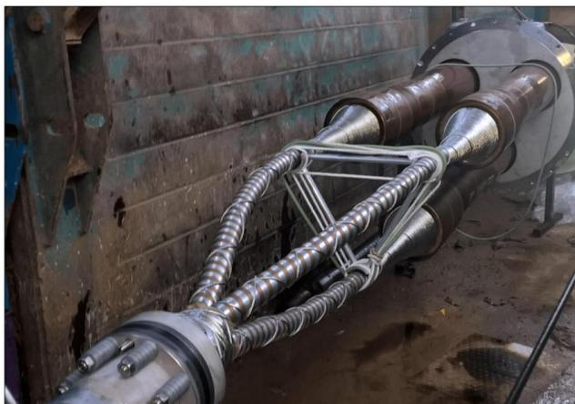
**Figura 39: Tipico di giunto di transizione tra cavi marini e terrestri**
