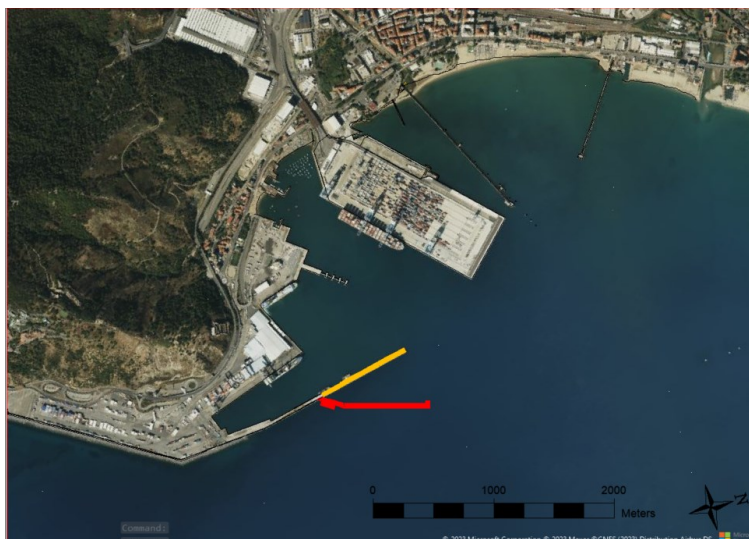
Figura 1.2 - Fase 1 in corso di realizzazione nell'ambito dell'appalto denominato P.742
