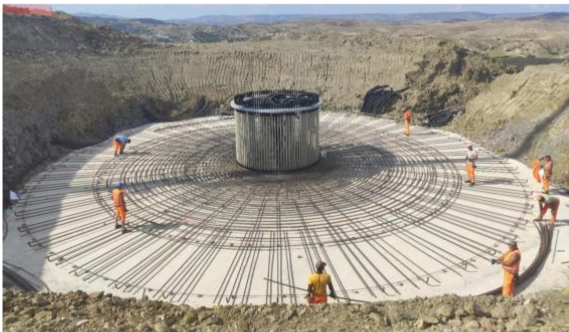
Figura 8 - Posa anchor cages tipo
