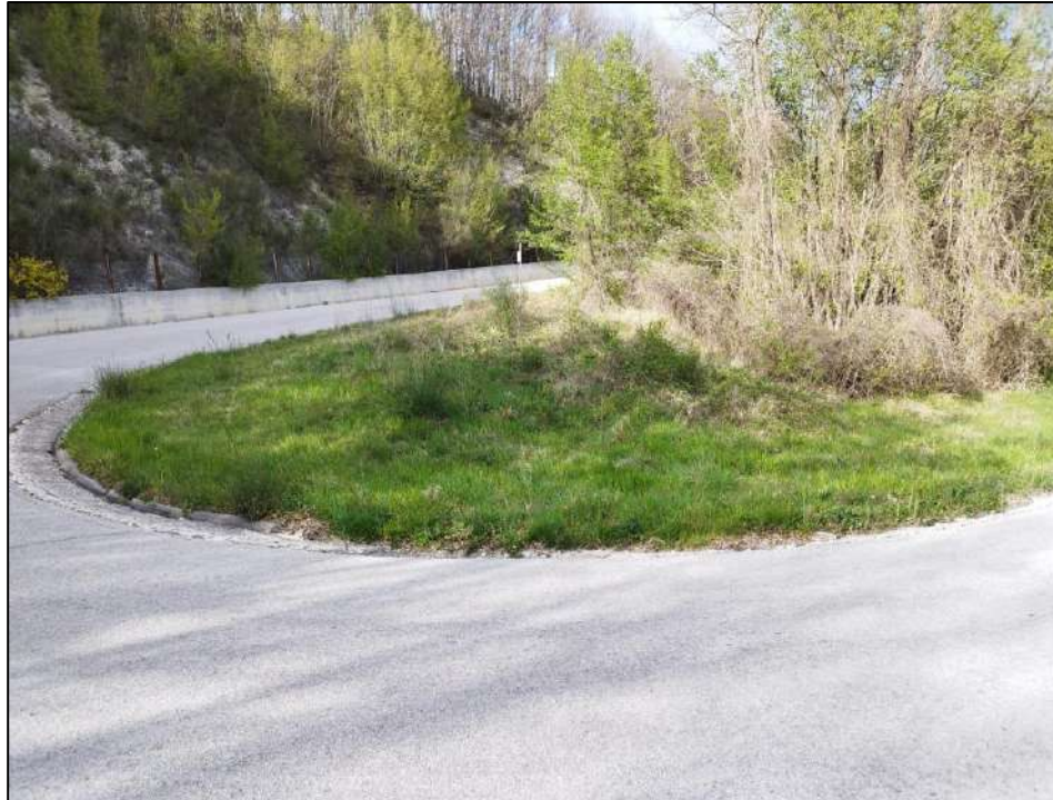
Figura 126: Parte interna della curva
