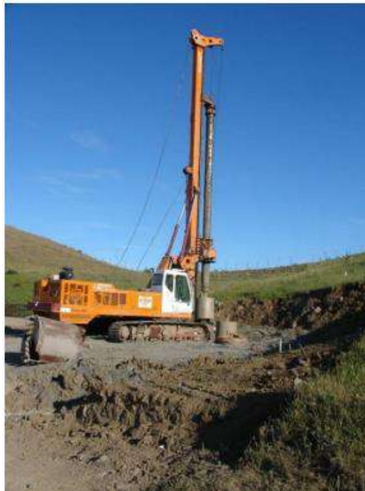
Figura 24 - Esecuzione dei pali di fondazione di un aerogeneratore
