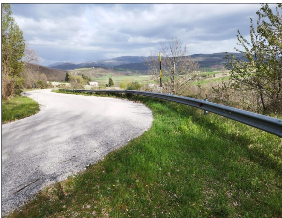
Figura 79: Parte esterna della curva
