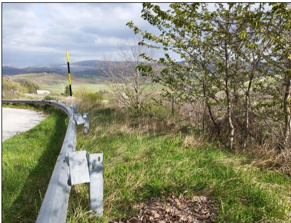
Figura 78: Parte esterna della curva
