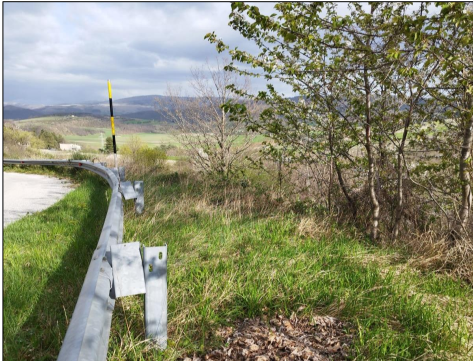
Figura 98: Parte esterna della curva
