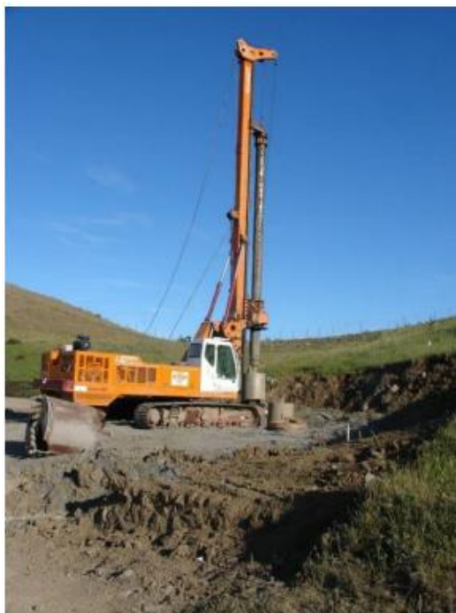
Figura 17 - Esecuzione dei pali di fondazione di un aerogeneratore
