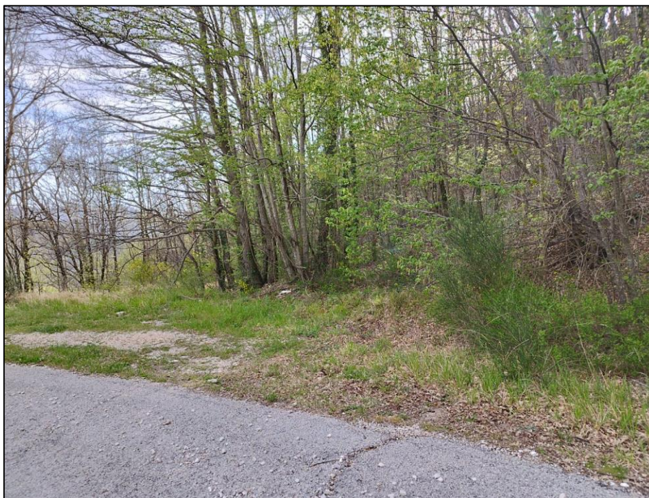
Figura 108: Parte esterna della curva
