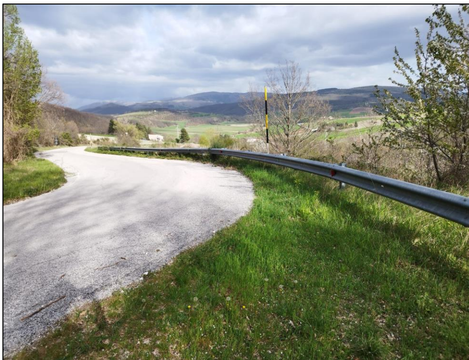
Figura 107: Parte esterna della curva
