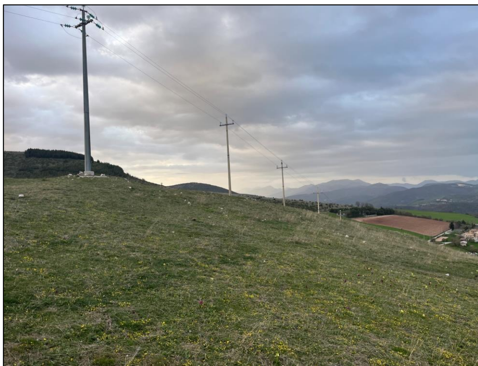
Figura 73: IMG_06 Punto di scatto in direzione dell'aerogeneratore FO06
