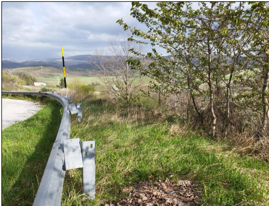
Figura 106: Parte esterna della curva
