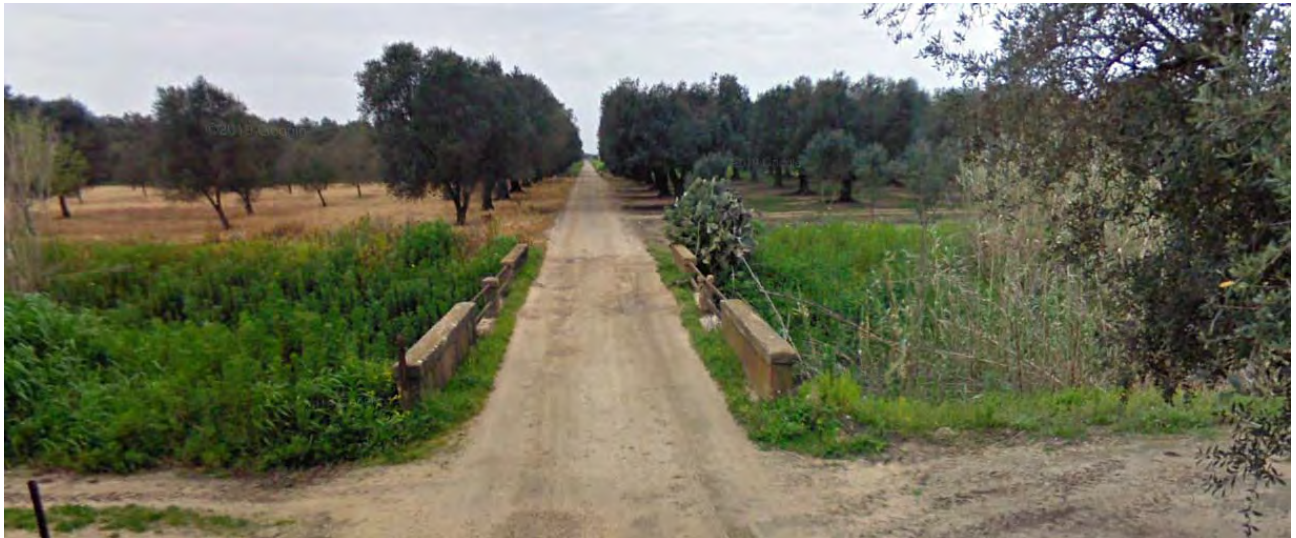
Figura 6-29 - Foto della Strada Provinciale 81 che attraversa e interrompe l'area perimetrata e definita come "UCP - Formazioni Arbustive"
