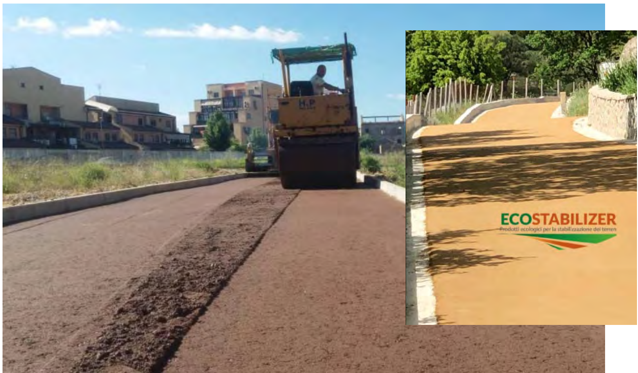
Figura 10-3 - Esempi di strade in terra stabilizzata
