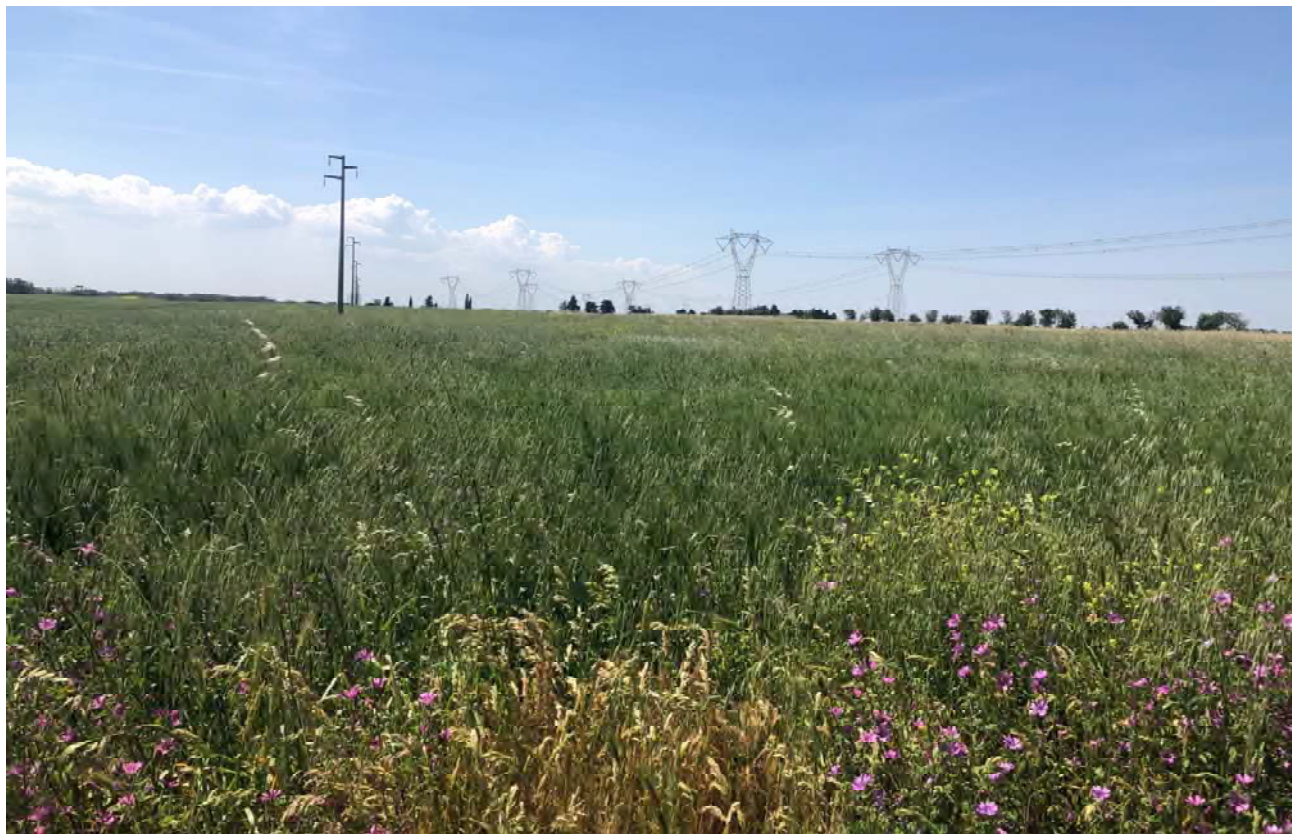
Figura 8-2 - Punto di presa 1 (Sotto-impianto FV-Parisi)
