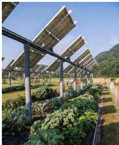
Figura 3-1 - Esempio di integrazione tra attività agricola e produzione di energia da fonte fotovoltaica
