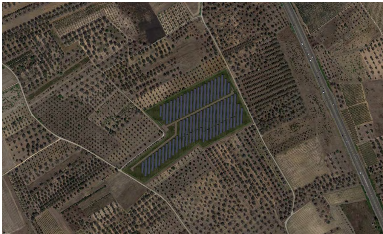
Figura 13-6 - Fotoinserimento sotto-impianto FV-Leanzi – vista dall’alto
