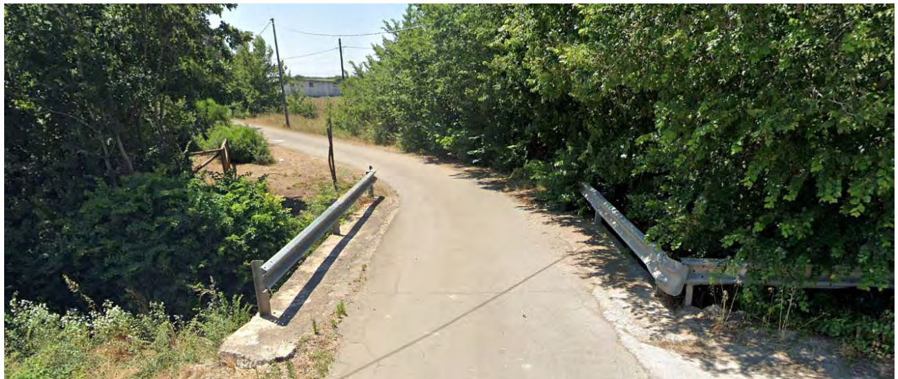
Figura 6-31 - Foto della Strada Comunale 23 che attraversa e interrompe l'area perimetrata e definita come "UCP - Formazioni Arbustive"
