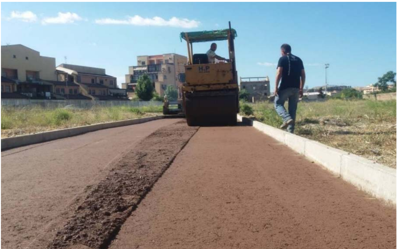
Figura 5-3 - Esempi di strade in terra stabilizzata
