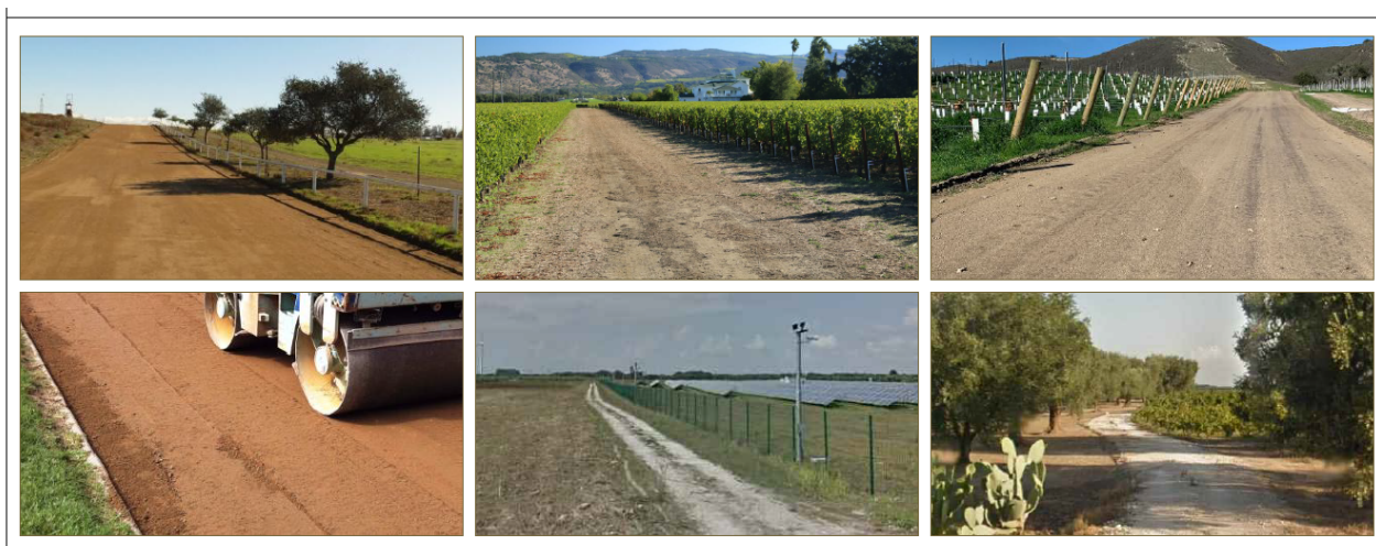
Figura 4-43 - Esempi di strade in terra stabilizzata
