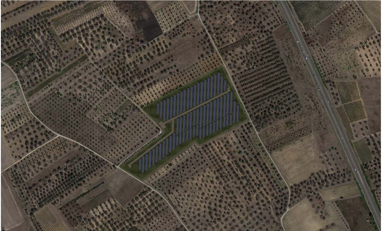
Figura 4-67 - Fotoinserimento sotto-impianto FV-Leanzi – vista dall’alto
