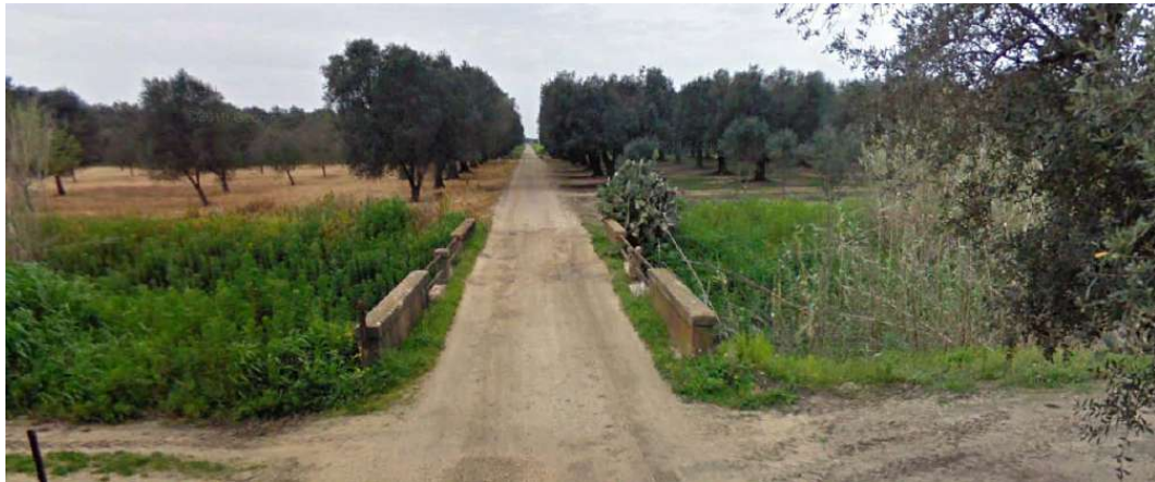
Figura 3-47 - Foto della Strada Provinciale 81 che attraversa e interrompe l'area perimetrata e definita come "UCP - Formazioni Arbustive"
