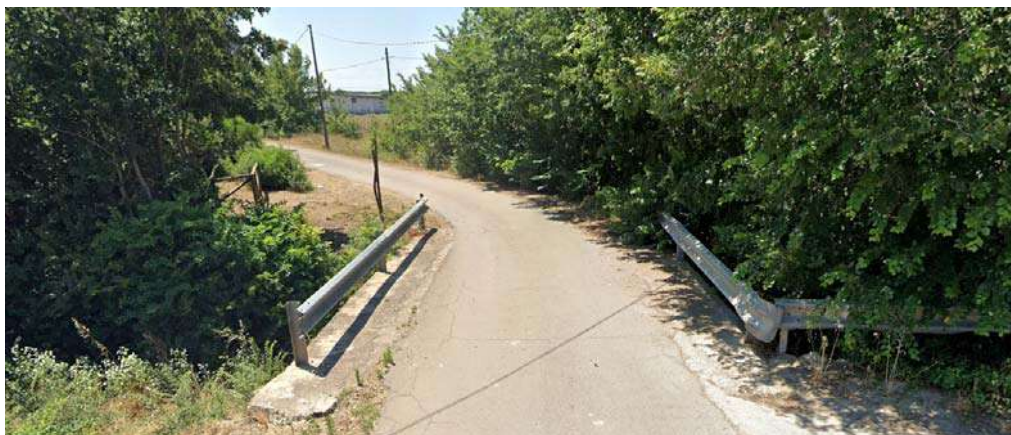
Figura 3-49 - Foto della Strada Comunale 23 che attraversa e interrompe l'area perimetrata e definita come "UCP - Formazioni Arbustive"
