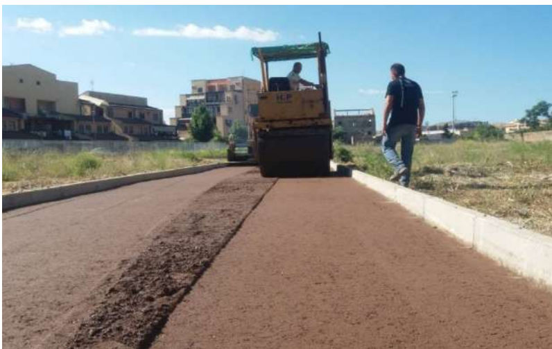
Figura 6-3 - Esempi di strade in terra stabilizzata
