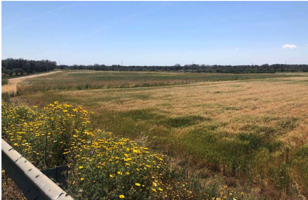
Figura 5-62 - Punto di presa 6 (Sotto-impianto FV-Bardi Vecchi)
