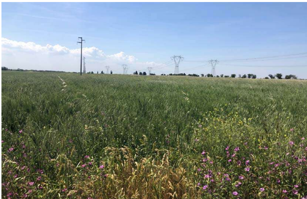
Figura 5-55 - Punto di presa 1 (Sotto-impianto FV-Parisi)
