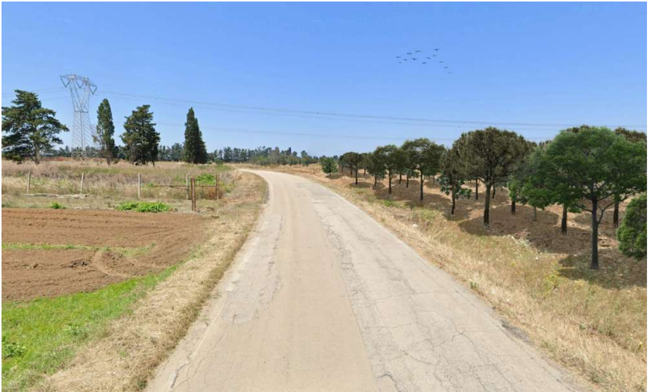
Figura 5-83 - Vista dal punto di presa 1 del sotto-impianto FV-Parisi dalla Strada Provinciale SP80 adiacente – Post operam
