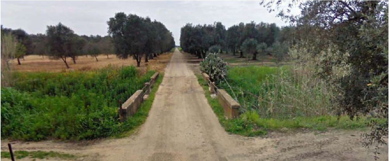
Figura 3-59 - Foto della Strada Provinciale 81 compresa all'interno dell'area tutelata denominata "BP- Fiumi, torrenti, corsi d'acqua iscritti negli elenchi delle acque pubbliche (150 m)"
