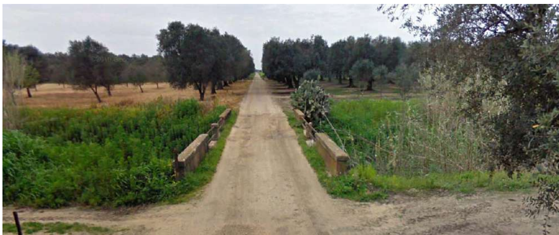
Figura 3-130 - Foto della Strada Provinciale 81 compresa all'interno dell'area tutelata denominata "BP- Fiumi, torrenti, corsi d'acqua iscritti negli elenchi delle acque pubbliche (150 m)"
