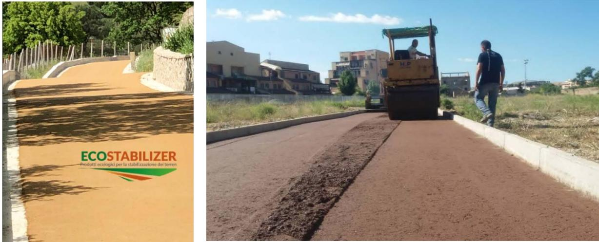
Figura 7-3 - Esempi di strade in terra stabilizzata
