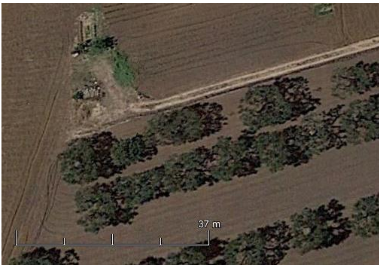
Figura 3.1.8 Ortofoto 2017 Impianto FV Aviso dettaglio struttura diruta
