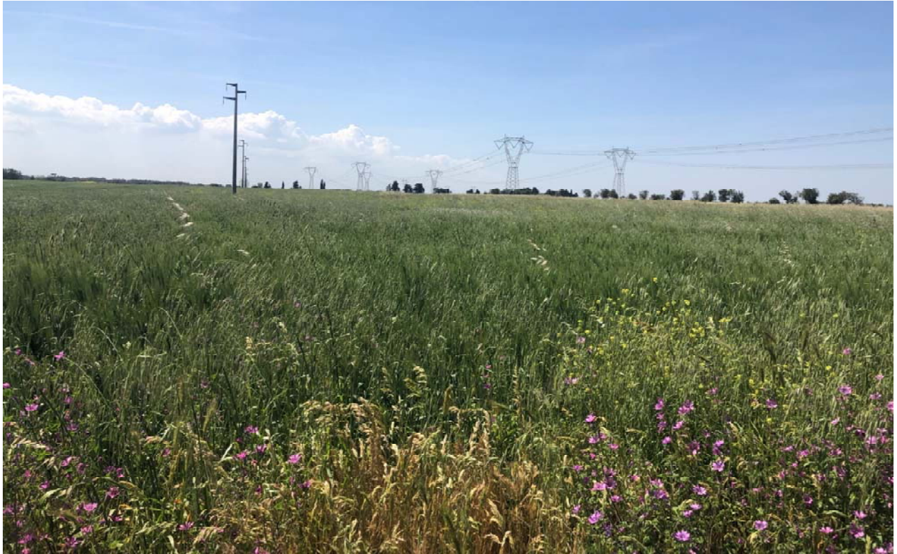
Figura 2-2 - Punto di presa 1 (Sotto-impianto FV-Parisi)
