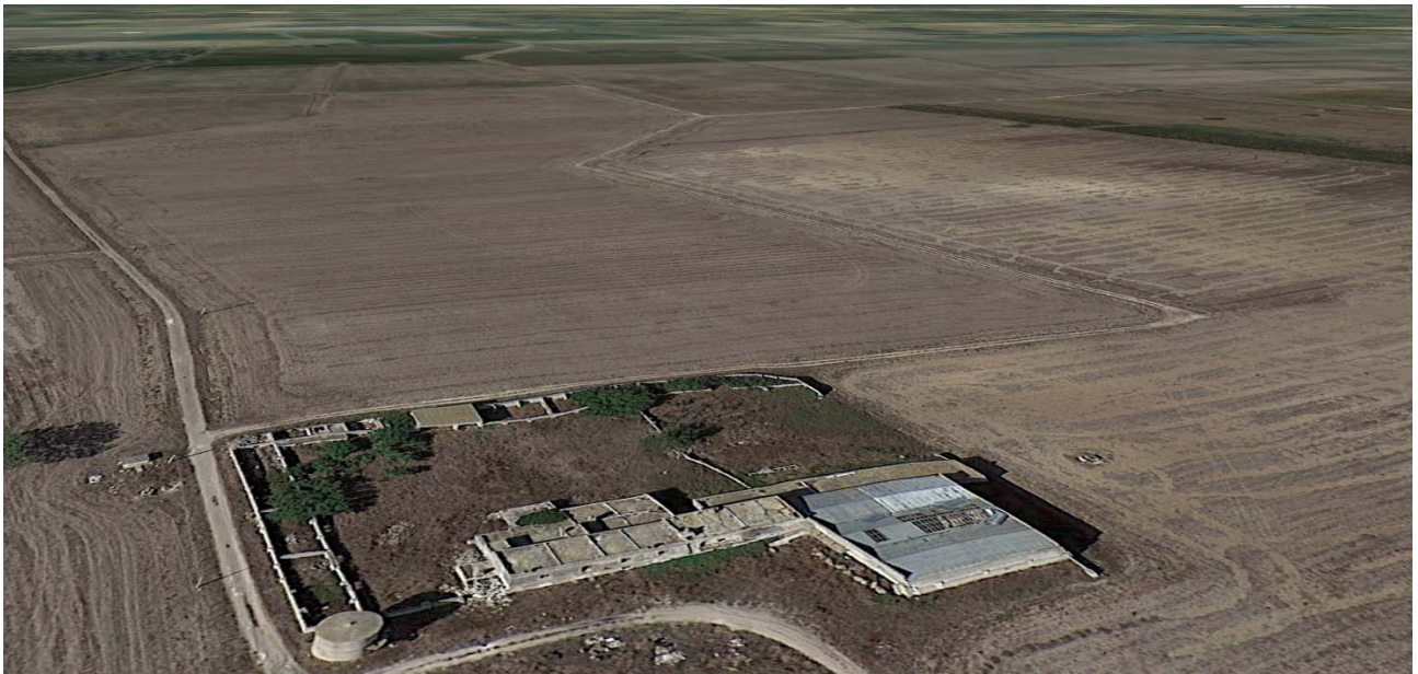
Figura 5-7 Punto di presa fotografica P4 - vista a volo d'uccello (Masseria Santa Teresa)
