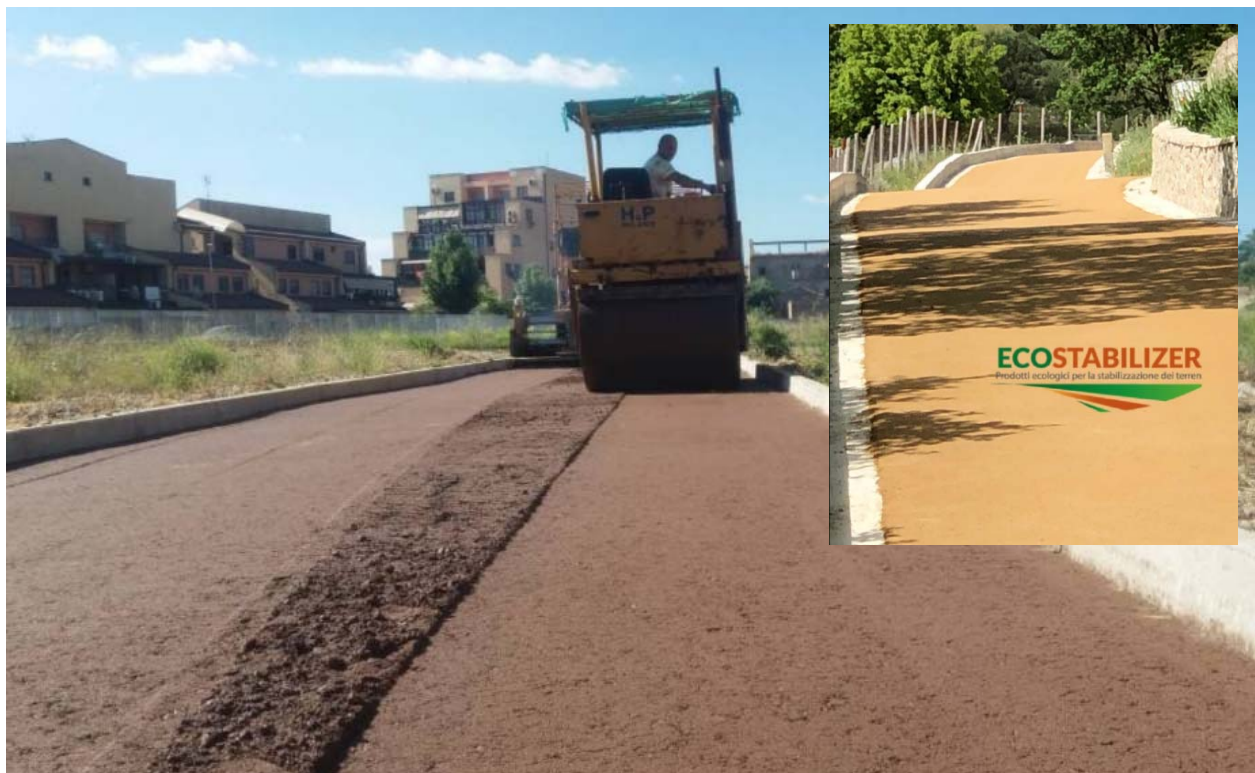
Figura 7-3 - Esempi di strade in terra stabilizzata
