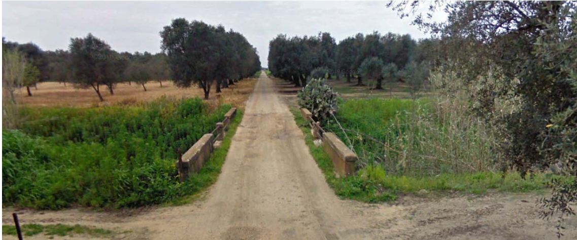
Figura 6-12 - Foto della Strada Provinciale 81 compresa all'interno dell'area tutelata denominata "BP- Fiumi, torrenti, corsi d'acqua iscritti negli elenchi delle acque pubbliche (150 m)"
