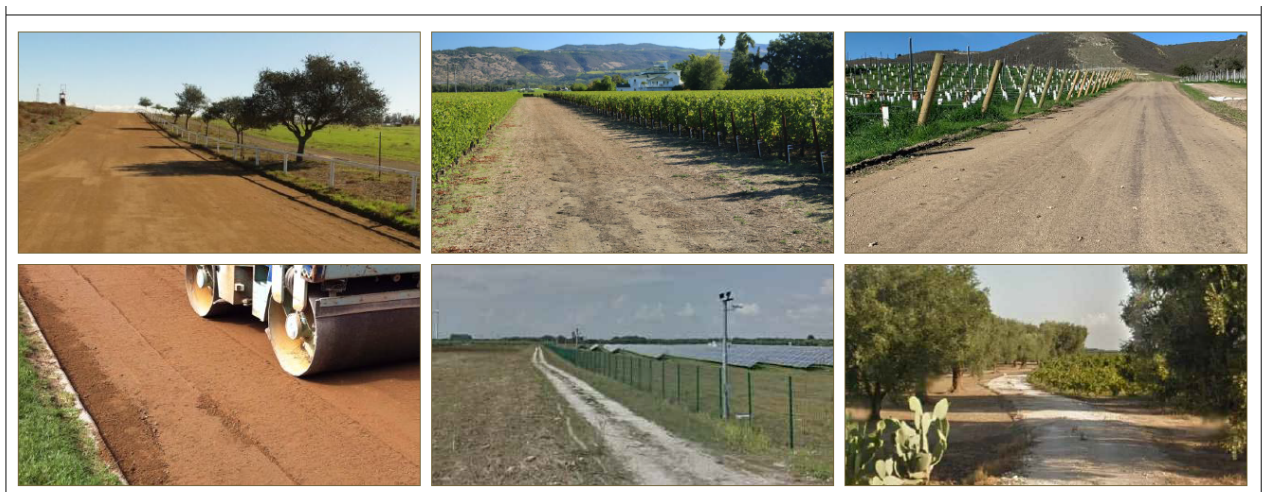
Figura 17-2 - Esempi di strade in terra stabilizzata
