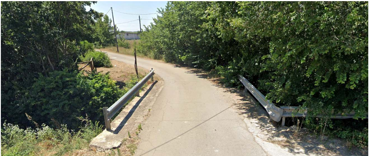
Figura 2-6 - Foto del punto di interferenza tra il tracciato del cavidotto MT di parallelo interrato lungo la Strada Comunale 23 e l'area tutelata denominata "UCP - Reticolo idrografico di connessione della R.E.R. (100 m)"
