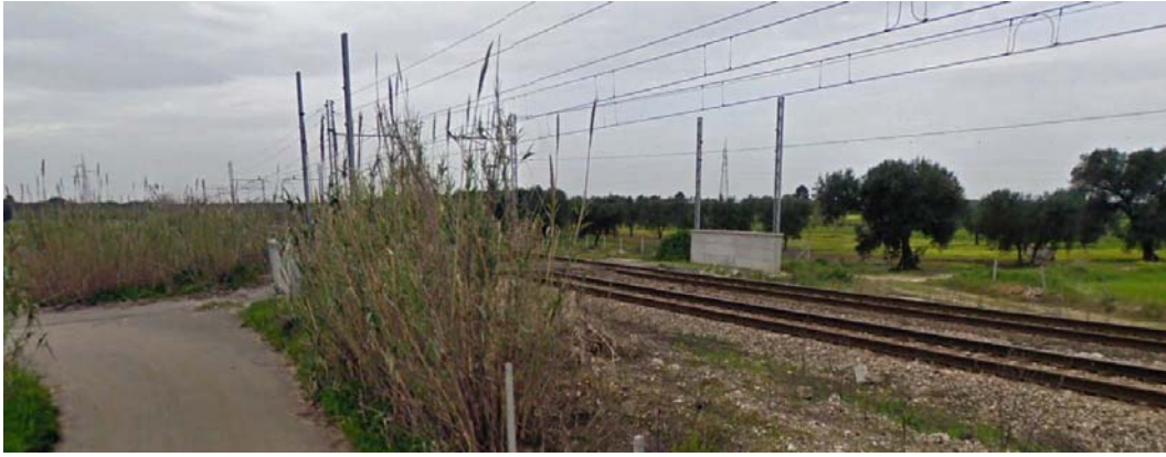
Figura 3-29 – Report fotografico dell'interferenza di attraversamento con TOC del cavidotto interrato in MT di parallelo con la rete ferroviaria esistente (punto n°49 – foto 1)
