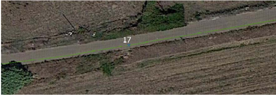
Figura 3-33 Interferenza di attraversamento con TOC del cavidotto interrato in MT di parallelo con una canaletta esistente trasversale alla strada (punto n°17)
