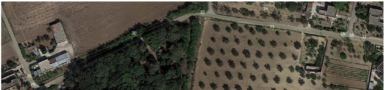
Figura 3-22 Interferenza di attraversamento e di fiancheggiamento tra la linea aerea BT e il cavidotto di parallelo interrato (punto n°28, n°30, n°34 e n°37); interferenza di attraversamento e di fiancheggiamento tra la linea aerea MT e il cavidotto di parallelo interrato (punto n°29, n°30, n°32, n°33, n°35 e n°36) – non rilevanti
