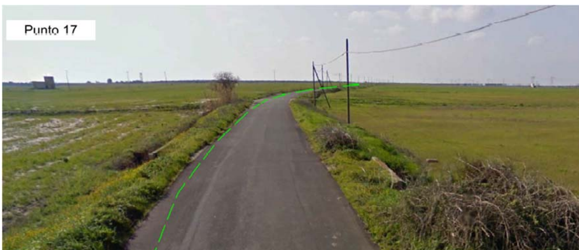
Figura 3-35 Report fotografico con ricostruzione esemplificativa del tracciato del cavidotto interrato in MT lungo la Strada Comunale 54 (punto n°17 – foto 2 direzione ovest) relativamente all'interferenza di attraversamento con TOC con una canaletta esistente trasversale alla strada
