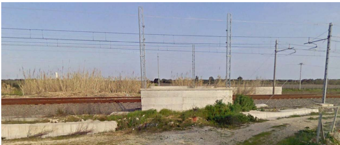
Figura 3-31 Report fotografico dell'interferenza di attraversamento con TOC del cavidotto interrato in MT di parallelo con la rete ferroviaria esistente (punto n°49 – foto 3)
