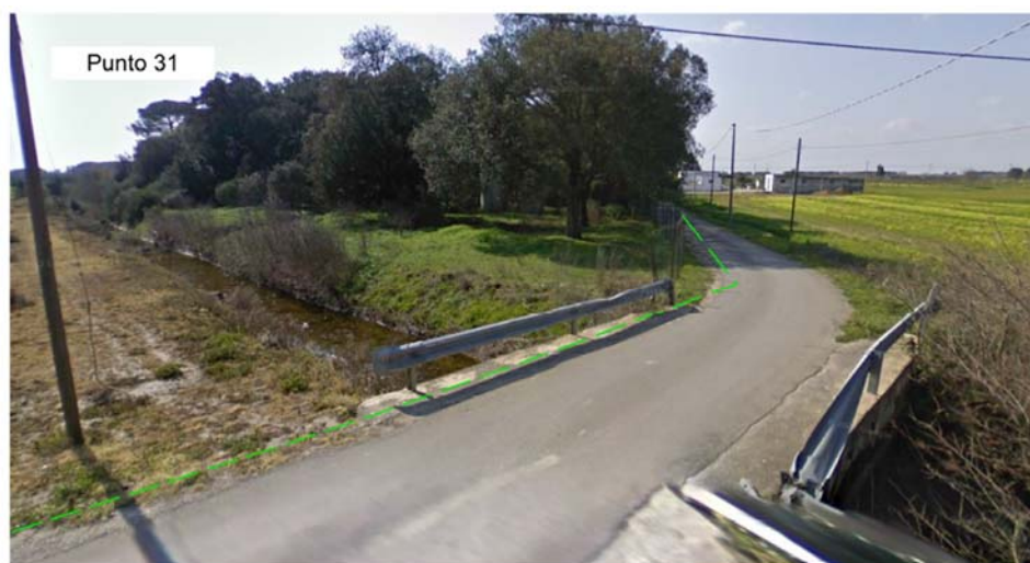
Figura 3-37 - Report fotografico con ricostruzione esemplificativa del tracciato del cavidotto interrato in MT lungo la Strada Comunale 23 (punto n°31 – foto 1) relativamente all'interferenza di attraversamento con il ponte esistente
