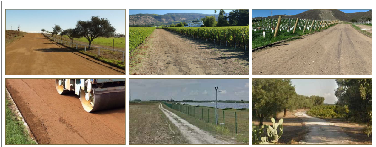
Figura 4-16 - Esempi di strade in terra stabilizzata
