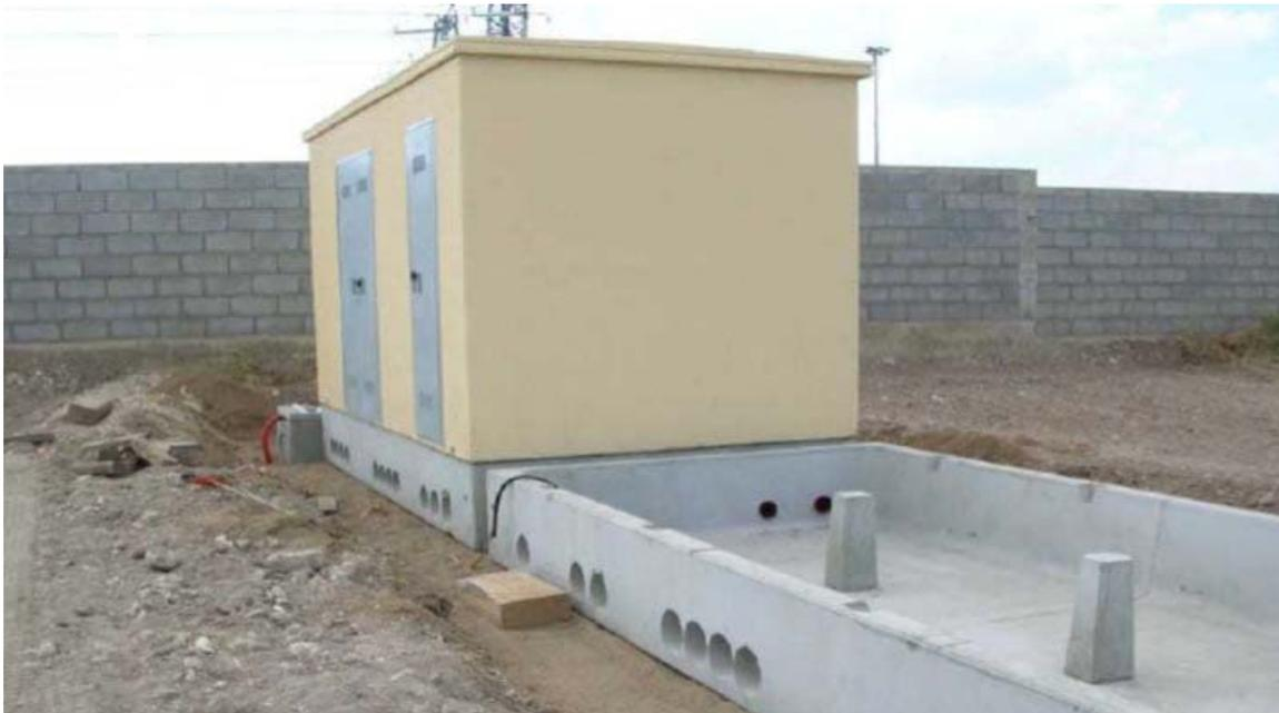
*Figura 4-10 - Particolare esempio di posa in opera dei locali cabine*
