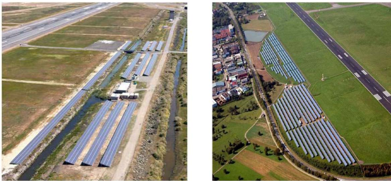
Figura 5 - Esempi di impianti fotovoltaici in ambito aeroportuale. La disposizione dei moduli fotovoltaici in prossimità delle piste di atterraggio/decollo non rappresenta un rischio per la sicurezza.
