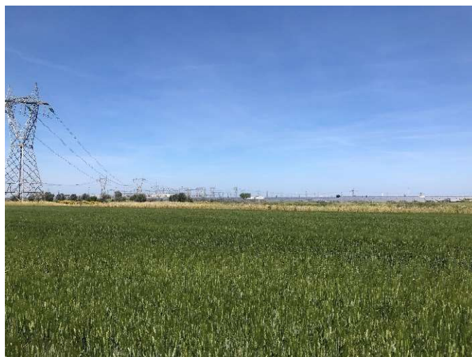
15– report fotografico stato di fatto areale di intervento – punto di presa 6
